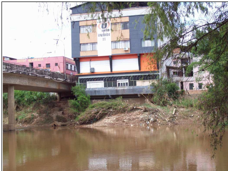
Foto 7.19. Ocupação em área de risco de enchente na planície de inundação do Rio Verde na área urbana de Três Corações. A presença de adensamento urbano e industrial nesse setor confere predomínio das estruturas antropogênicas na composição da paisagem.
