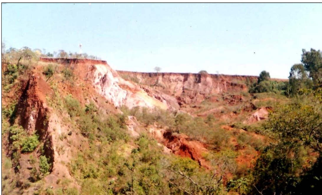
7.33. Voçoroca na área urbana de Cruzília, caracterizada por profundo entalhamento vertical associado a desabamentos laterais.
