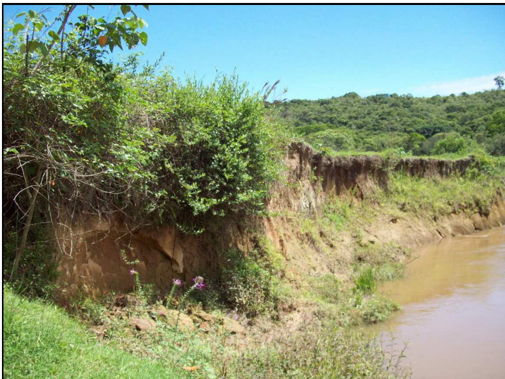
Foto 6.6. Diques marginais na margem esquerda do Rio Verde (São Sebastião do Rio Verde).
