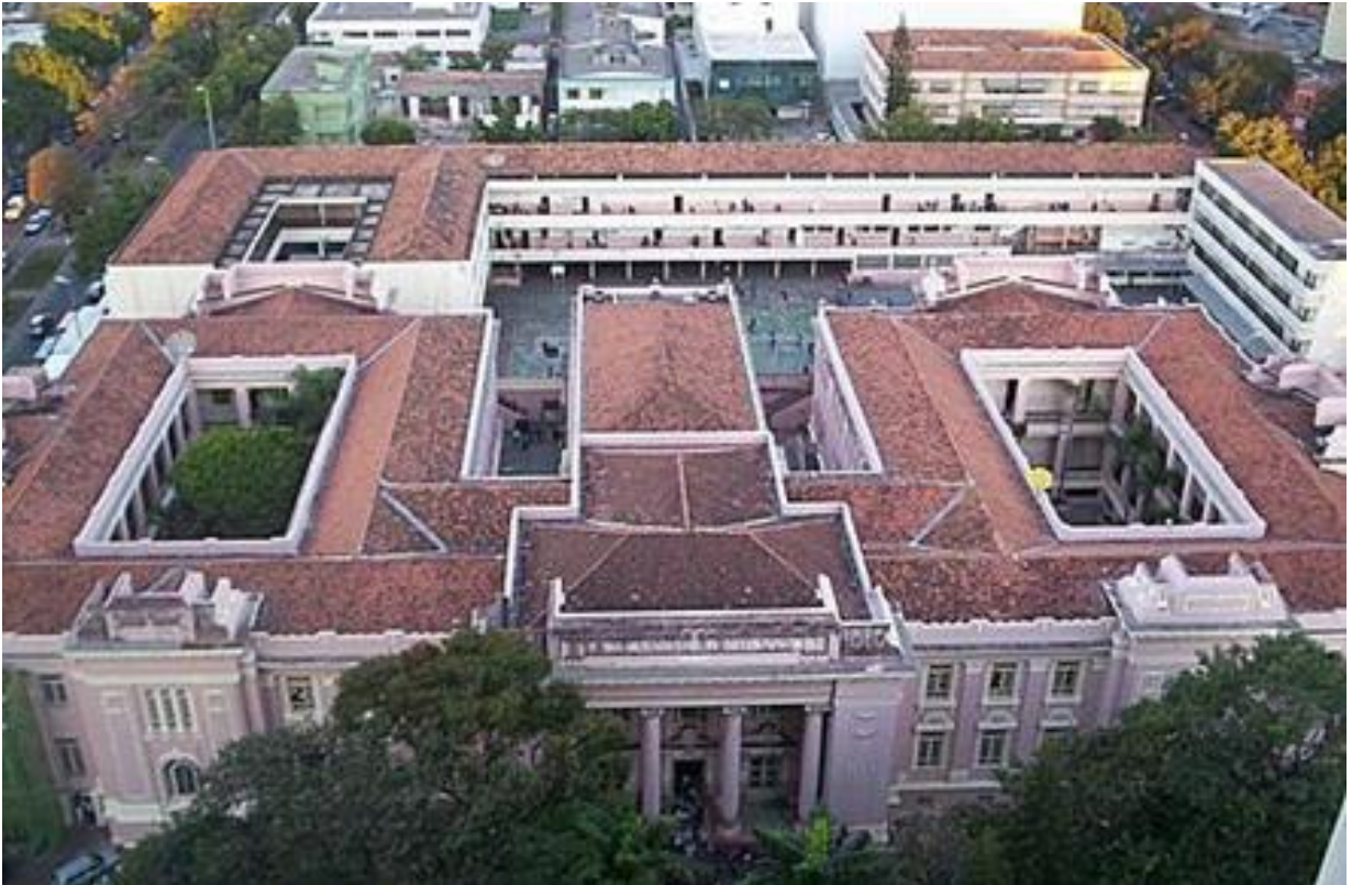
Figura 5 - Vista aérea do IEMG
