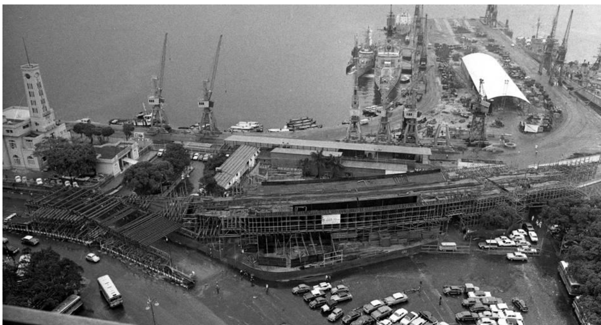
Figura 39 – Construção do Elevado da Avenida Perimetral, Praça Mauá, 1969.
