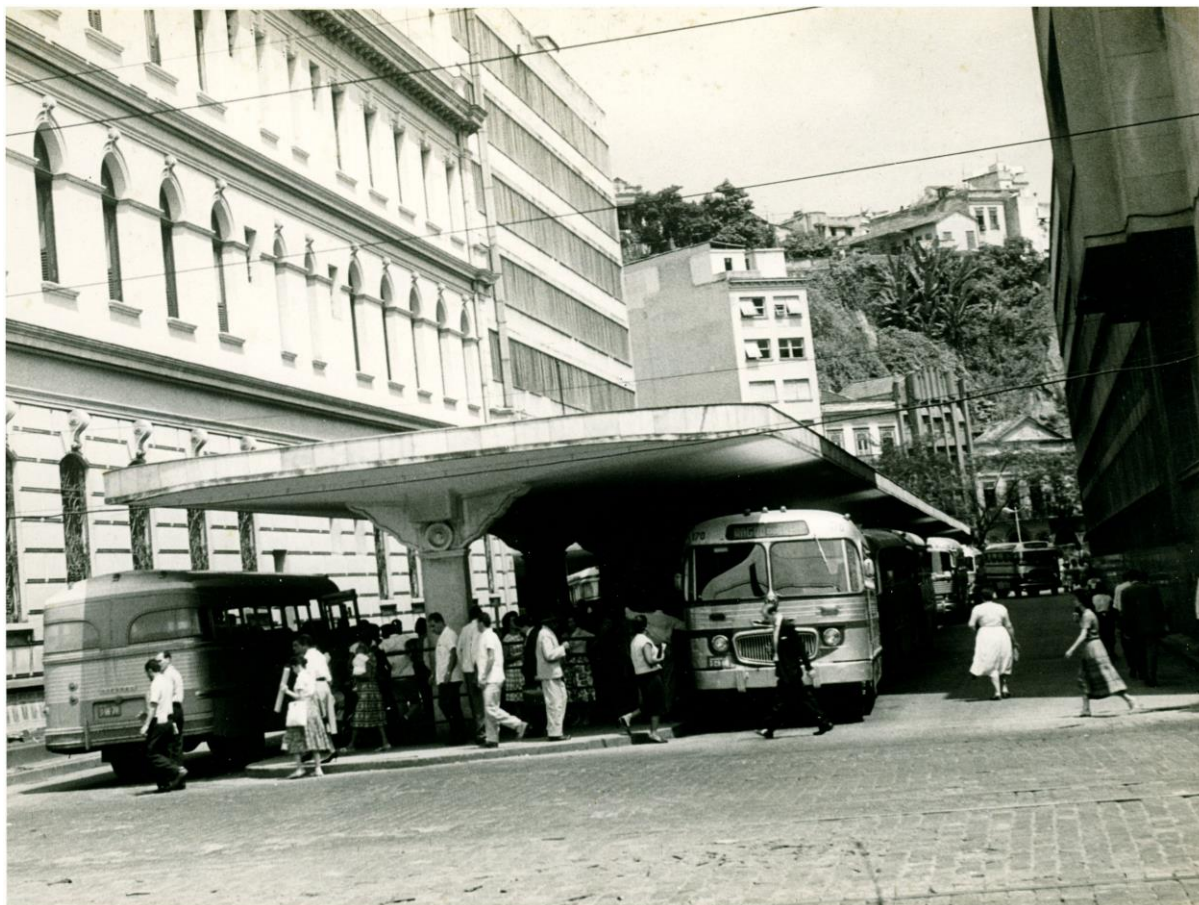
Figura 32 – Marquise do Terminal Rodoviário Mariano Procópio. À esquerda, parte do Palacete Dom Joao VI, seguido do edifício do terminal.
