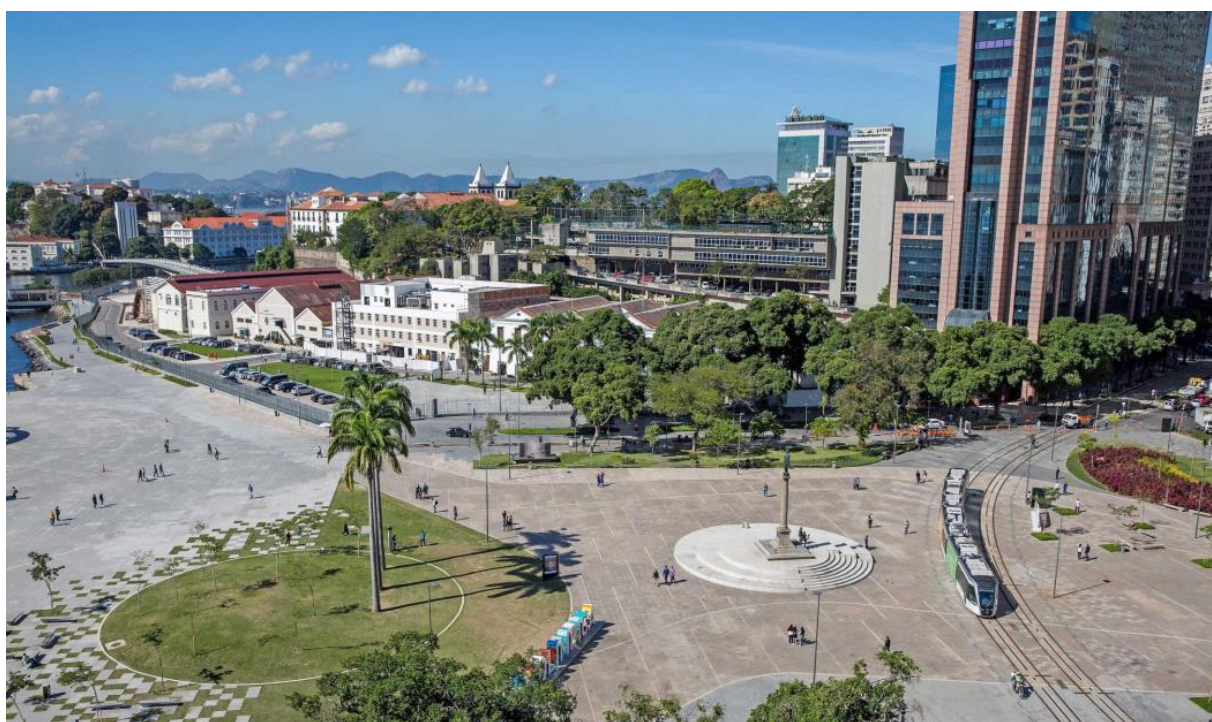
Figura 53 – Praça Mauá depois da demolição do Elevado da Avenida Perimetral
