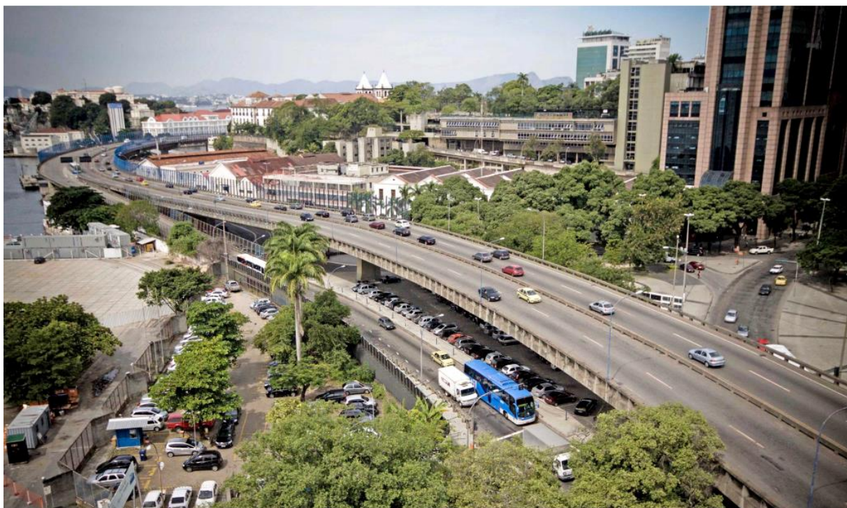
Figura 52 – Praça Mauá antes da demolição do Elevado da Avenida Perimetral.
