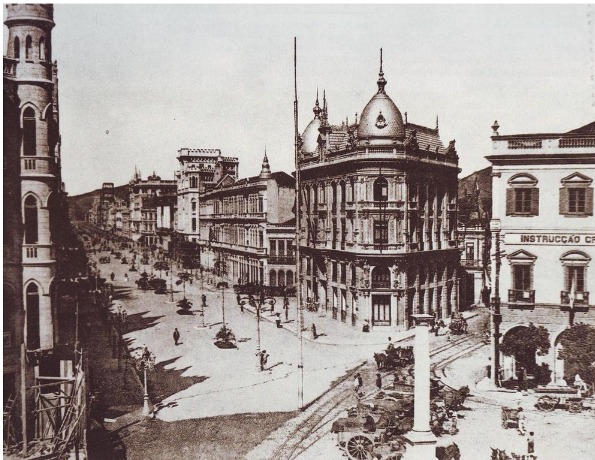
Figura 17 – Extremo norte da Avenida Central, Praça Mauá, c. 1910. Pedestal para instalação da Estátua do Barão de Mauá, em primeiro plano.
