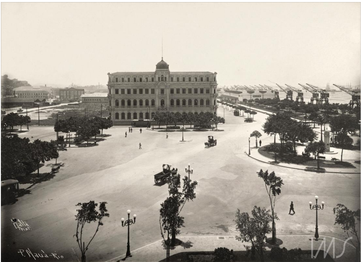
Figura 19 – Palacete Dom João VI, prédio da Inspetoria de Portos e Canais, 1920.
