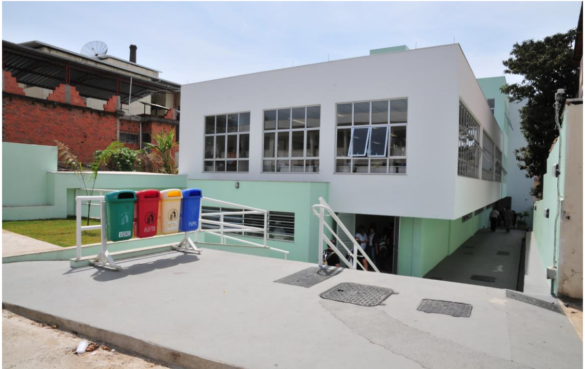
Prédio no qual o Restaurante se localiza, no térreo do Instituto Federal de Educação, Ciência e Tecnologia do Sudeste de Minas Gerais, Campus Juiz de Fora. Fonte: Arquivo da Assessoria de Comunicação do IF SUDESTE MG, Campus Juiz de Fora.
