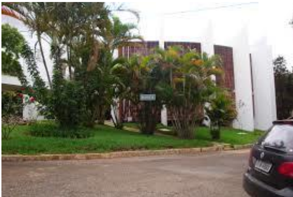
Figura 7: Vista da entrada da sede da Magistra – Campus Gameleira
