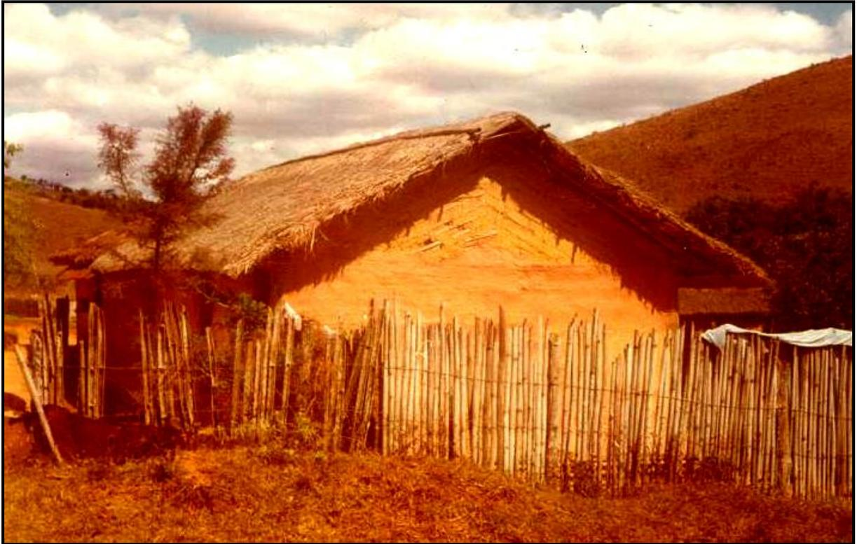
**Figura 8 – Casa de pau-a-pique, típica da antiga localidade de Paraibuna, antes da formação da Represa de Chapéu D’Uvas. (Foto: Sondotécnica, 1982a:11)**
