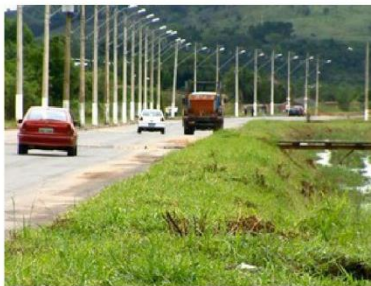
Cerca de 44% da construção foi concluída na rodovia (Foto: Reprodução/ TV Integração)
