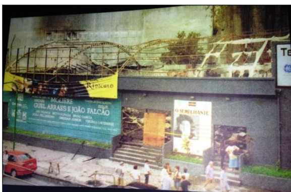
Figura 10 – Teatro Casa Grande destruído pelo incêndio. Fonte: Teatro Oi Casa Grande.
