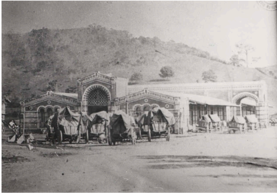
Estação Rio Novo. Disponível em: Acesso em: 14/12/2015.
