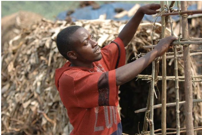
Figura 12 :Morador montando a estrutura da nova cabana
