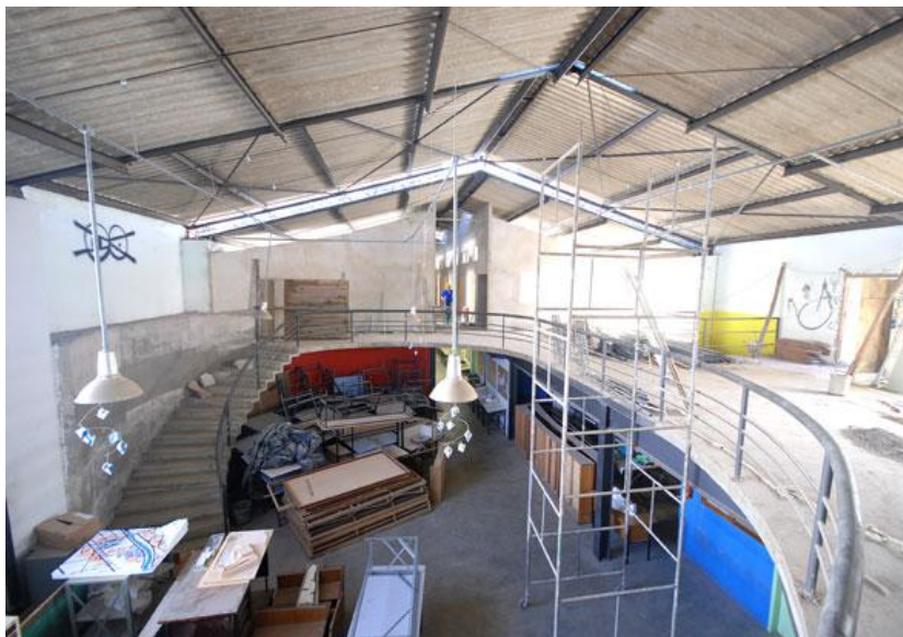
Figura 4 Reformas do galpão em 2007
