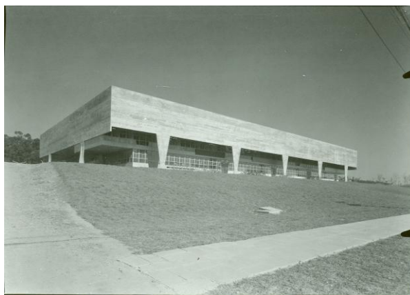
Figura 9- Fotografia da FAU-USP pouco tempos após a conclusão das obras. Autoria: Desconhecida.
