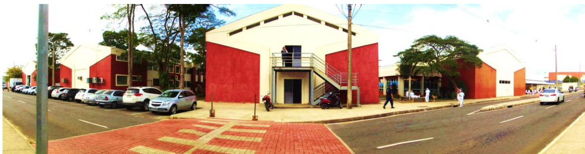
Figura 51 - Fotografia da Fachada dos Fundos do Galpão da Arquitetura
