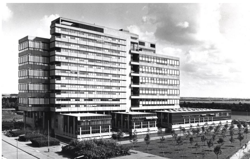
Figura 19 - O projeto de Broek e Bakema para a faculdade de Arquitetura de Delft. Autoria: Broek e Bakema
