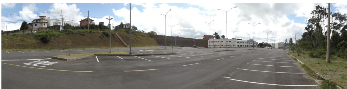
Figura 64 - Fotografia Panorâmica do Terreno onde se inserirá a FAU-UFJF
