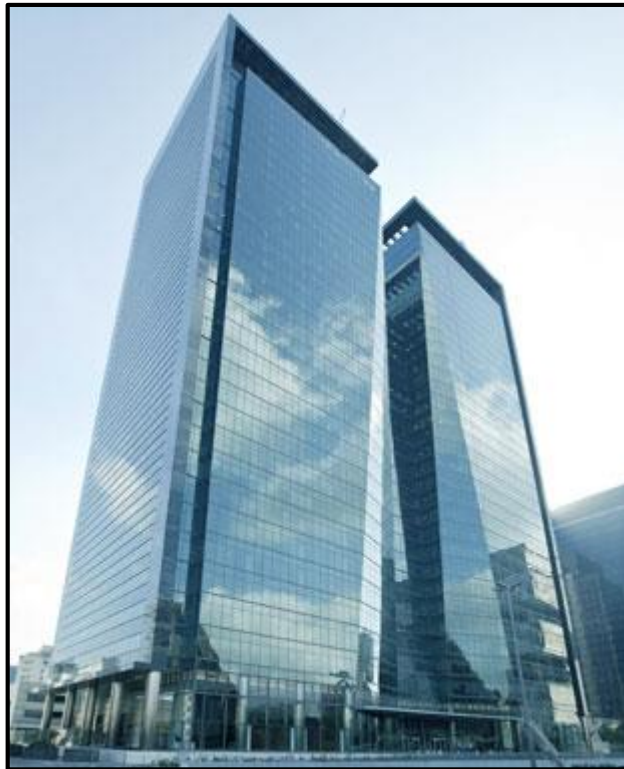
Figura 46 - Fachada Cortina - Ventura Tower Rio de Janeiro - Projeto Aflalo & Gasperini
