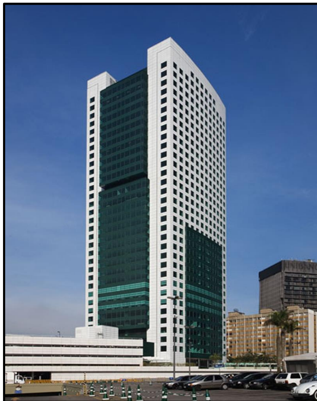
Figura 47 - Fachada Semi-Cortina - Edifício Eldorado Business Tower
