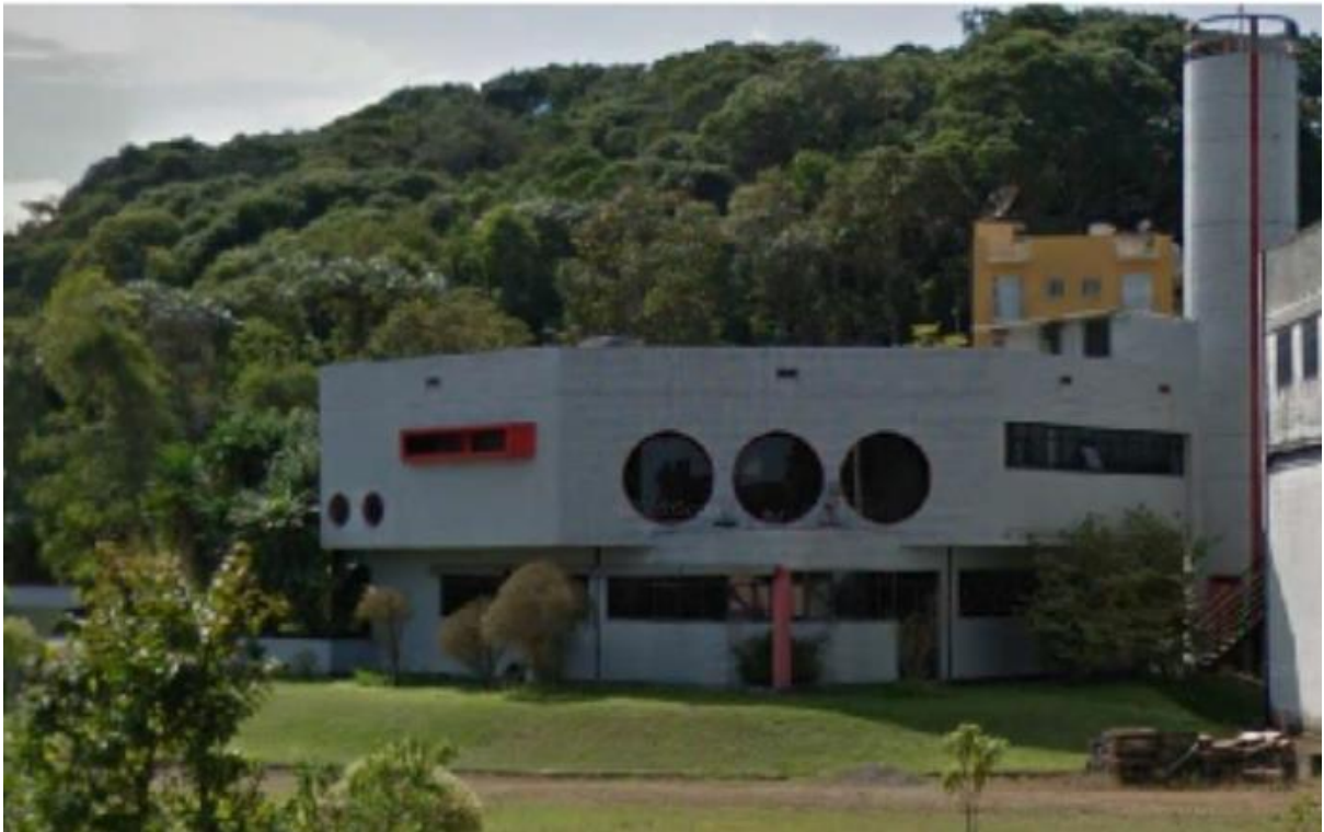
Figura 66– Fachada sul da Quiral Química. Fonte: Google Street View
