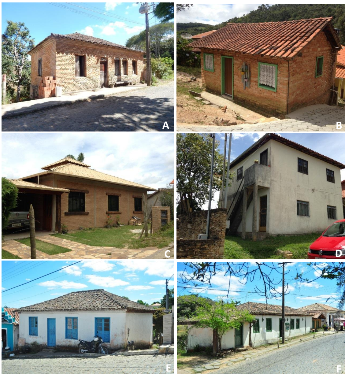
Figura 18: A. Casa de uso residencial do Jucundiano Chaves, ano de construção: aprox. 1920 – 1ª Casa com estrutura e vedação em tijolos maciços à vista da vila; B. Casa de uso residencial, ano de construção: aprox. 1940 – Estrutura e vedação em tijolos maciços; C. Casa de uso residencial, ano de construção: 2015 – Vedação em tijolos maciços; D. Sobrado residencial no térreo e aluguel no 2º andar, ano de construção: 1985 – Estrutura e vedação de tijolos no térreo e vedação em lajotas rebocadas no segundo andar; E. Casa de uso residencial, ano de construção: aprox. 1920 – Estrutura e vedação em tijolos maciços rebocados e pintados; F. Pousada “Ar da Graça”, ano de construção: aprox. 1820 – Estrutura de madeira com vedação de pau-a-pique. Fotografias: Acervo pessoal.
