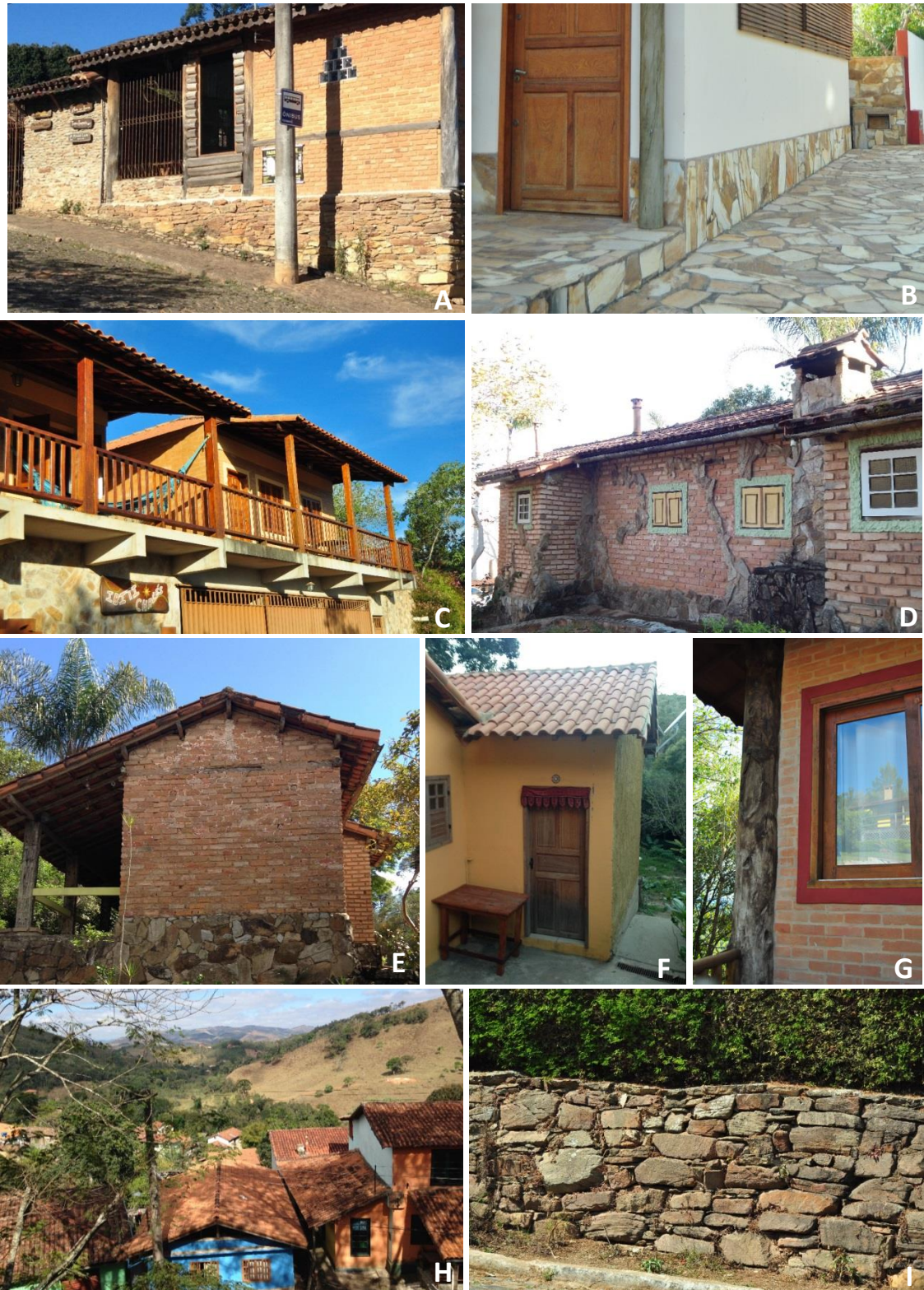
Figura 12: Elementos arquitetônicos construtivos encontrados. A. Shopping Portal da Serra, ano de construção: 2004 – Fundação em pedra seca. B. Casa de veraneio, ano de construção: aprox. 2010 – Fundação em concreto revestido de pedra. C. Suítes para aluguel, ano de construção: 2012 – Estrutura de concreto com laje. D. Pousada Janela do Céu: ano de construção 1984 – Tijolo maciço estrutural. E. Pousada Janela do Céu: ano de construção 1984 – Vedação tijolo à vista. F. Casa de aluguel, ano de construção: aprox. 1995 – Lajota estrutural. G. Casa de veraneio, ano de construção: 2012 – Esquadria de madeira. H. Telhados coloniais. I. Muro em pedra seca, ano de construção: aprox. 1990. Fotografias: Acervo pessoal.
