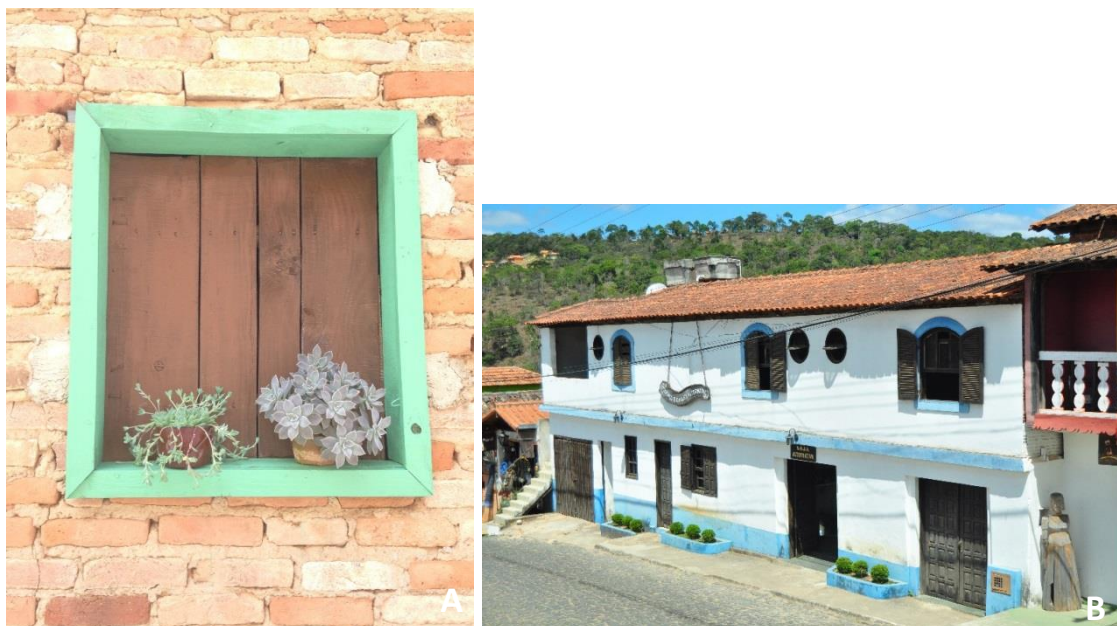
Figura 19: A. Casa de nativo, ano de construção: 1930 – Esquadrias de madeira original e preservada; B. Pousada “Alternativa”, ano de construção: 1985 – Uma das primeiras edificações com laje sobre tijolos estruturais. Exemplo de esquadrias e portões de madeira. Fotografias: Acervo pessoal.
