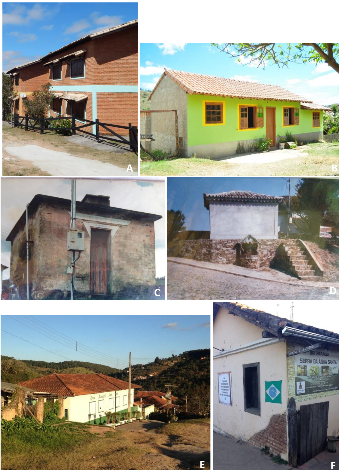
Figura 15: A. Casa de veraneio e aluguel, ano de construção: 2006 – Estrutura de concreto armado; B. Casa residencial, ano de construção: 2012 – Lajota estrutural e bloco estrutural; C. Caixa d’água da matriz, ano de construção: 1968 – colocação da 1ª laje de Conceição de Ibitipoca; D. Caixa d’água da matriz, ano de construção: 1995 – Colocação da cobertura e muros de pedra; E. Escola Municipal Padre Carlos, ano de construção: 1962 - Após a colocação do telhado colonial em 1996; F. Casa de uso comercial “Mãos de Maria” ou cada da Dona Laura, ano de construção: aprox. 1910 – 1ª casa de tijolo maciço estrutural a ser construída na Vila Conceição de Ibitipoca. Fotografias: Acervo pessoal.
