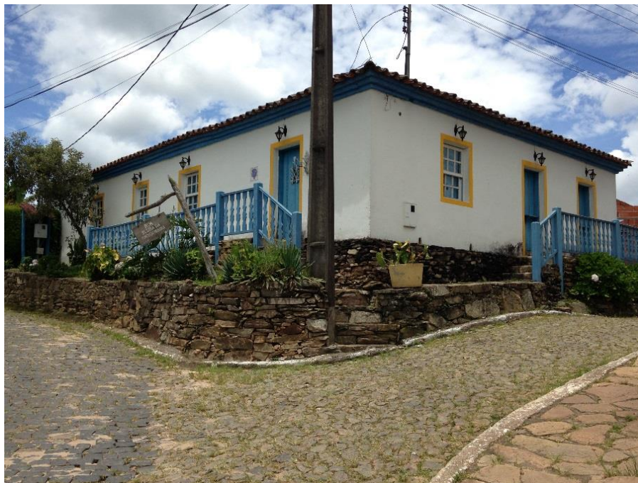
Figura 23: Casa do Antônio Chiquinha, data de construção: aprox. 1935 – Fundação e muro em pedra seca. Fotografia: Acervo pessoal.
