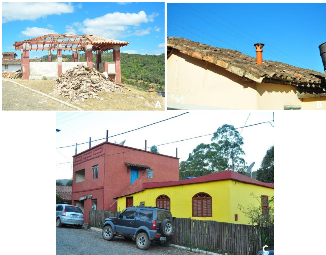
Figura 20: A. Coreto da Igreja Matriz Nossa Senhora da Conceição, data de construção: século XIX. – Reforma da cobertura com troca do madeiramento e substituição apenas das telhas curvas originais de baixo por telhas cerâmicas novas; B. Detalhe de um telhado em telha curva de 2 águas, data de construção: aprox. 1970; C. Edificações de uso residencial, data de construção: aprox. 1985 – Cobertura em laje exposta e platibanda, descaracterizantes na paisagem. Tentativa impedida por moradores de colocação de cobertura em telha galvanizada. Uso de cores vibrantes. Fotografias: Acervo pessoal.
