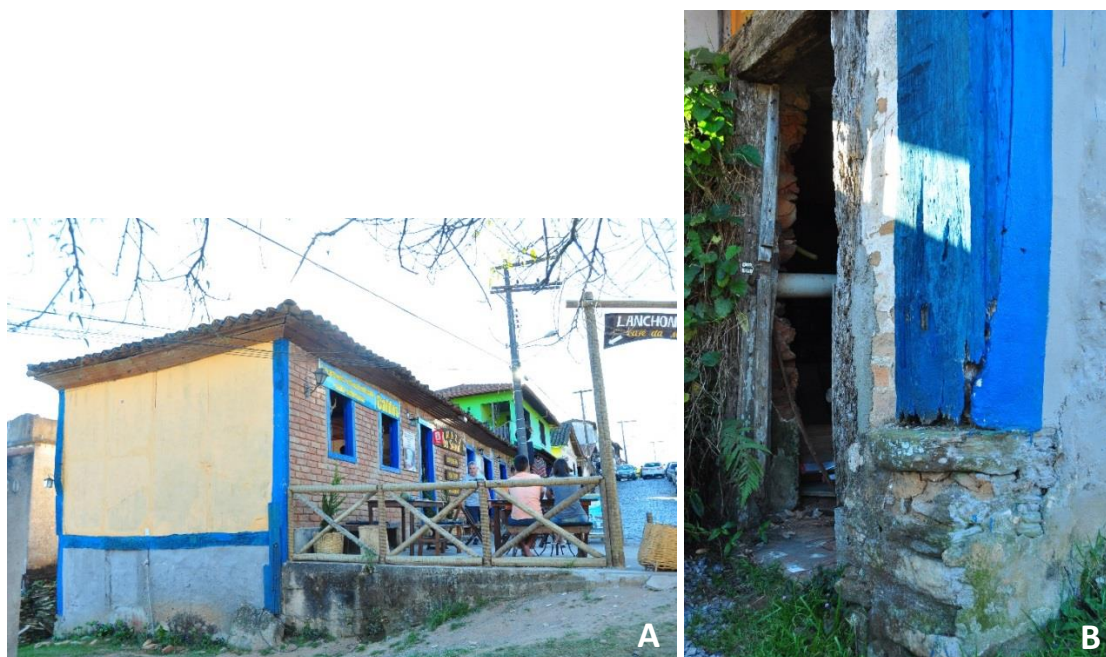
Figura 16: A. Casa de uso comercial muito conhecida como “Ibitipharma”, ano de construção: aprox. 1860 – Estrutura de madeira com pau-a-pique e fachada frontal refeita em tijolos maciços; B. Casa de uso comercial muito conhecida como “Ibitipharma”, ano de construção: 1860 – Detalhe da estrutura de madeira apoiada em fundação de pedra seca. Fotografias: Acervo pessoal.
