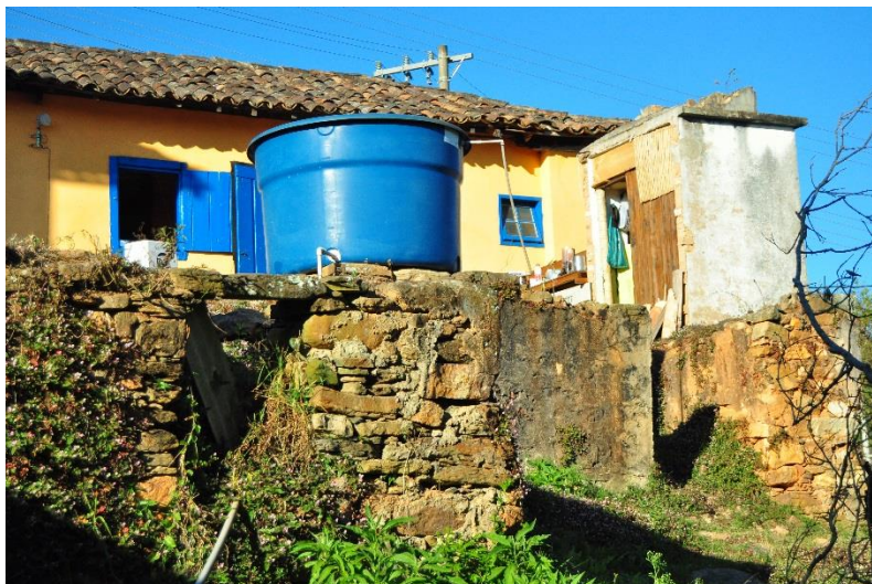
Figura 14: Edificação com uso comercial, ano de construção: aprox. 1850 – Fundação de pedra. Fotografia: Acervo pessoal.
