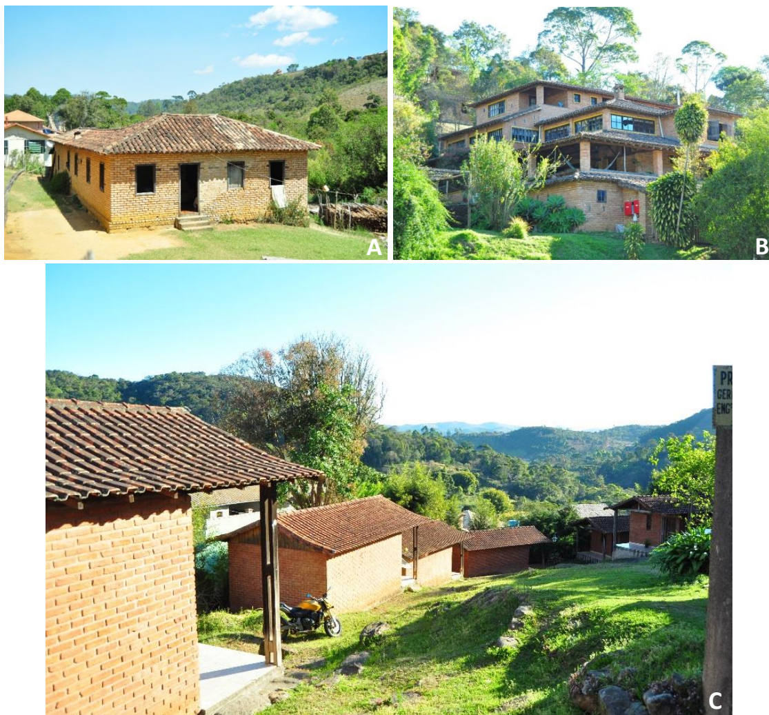
Figura 34: A. Casa do Sr. Nelson e Dona Maria do Pão de Canela, ano de construção: aprox. 1920. B. Sede da Repousada, ano de construção: 1987 - Vedação em tijolos à vista. C. Chalés para aluguel, ano de construção: 2001 – Estrutura e vedação em tijolos à vista. Fotografias: Acervo pessoal.
