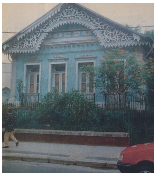
Figura 4: Vista do Chalé à época de seu tombamento
