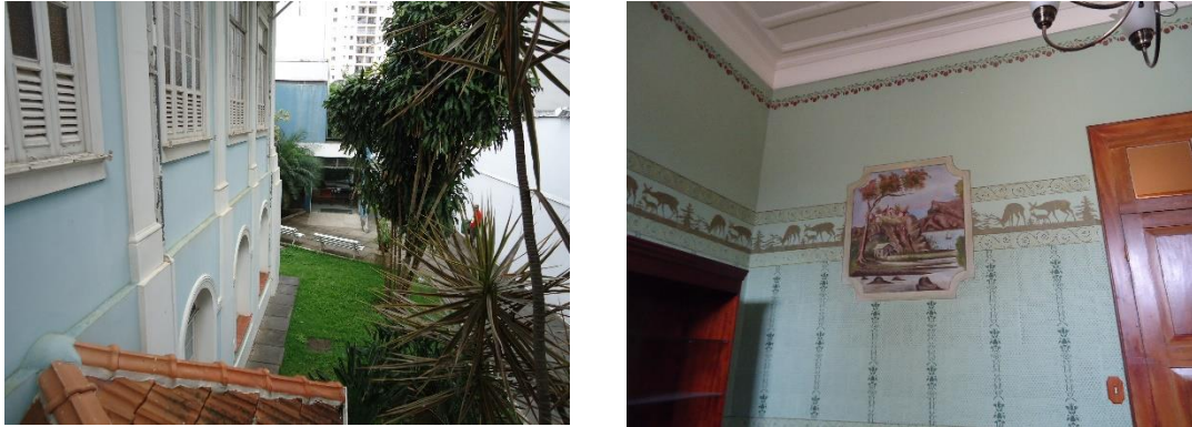
Figura 14: Pintura de parede externa, e detalhe de pintura artística na parede interna de uma das salas do pavimento superior
