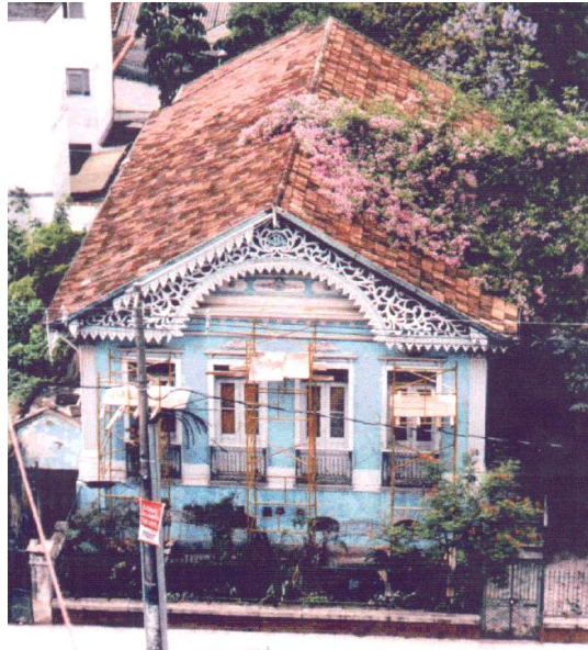
Figura 16: Vista da cobertura de telhas francesas em duas águas
