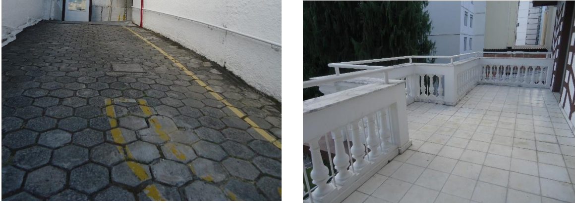
Figura 53: Blocos hexagonais da rua interna (à esquerda) e piso de mármore da varanda (à direita)
