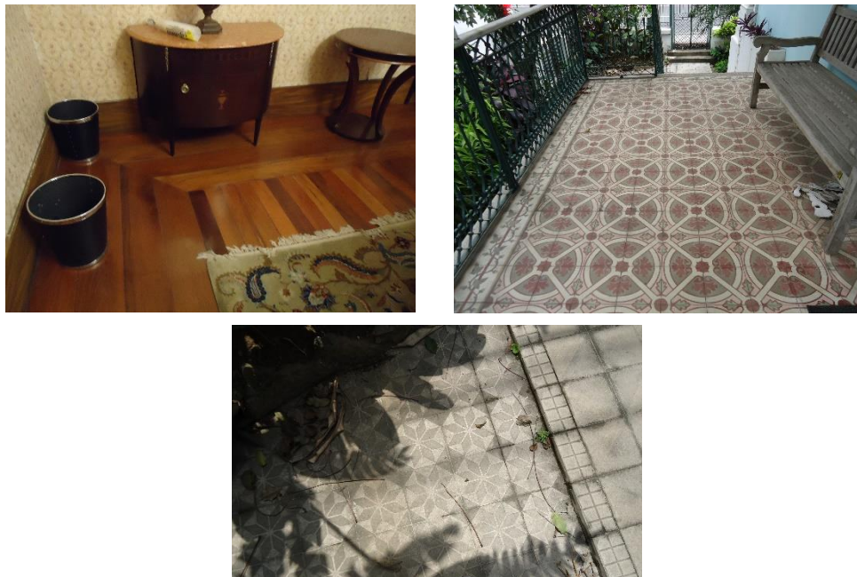
Figura 17: Piso de tábua corrida dos cômodos internos, piso de ladrilhos hidráulicos do alpendre, e piso de ladrilhos hidráulicos (já deteriorados) no jardim frontal de acesso ao alpendre
