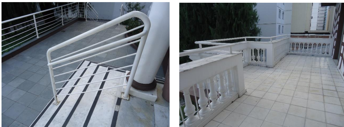
Figura 67: Detalhes de pequenas adaptações que o imóvel sofreu, como a instalação de corrimãos nas escadas, e o reforço na segurança dos balaústres das varandas, sempre prezando pela distinguibilidade das intervenções contemporâneas, além de intervir sempre o mínimo possível
