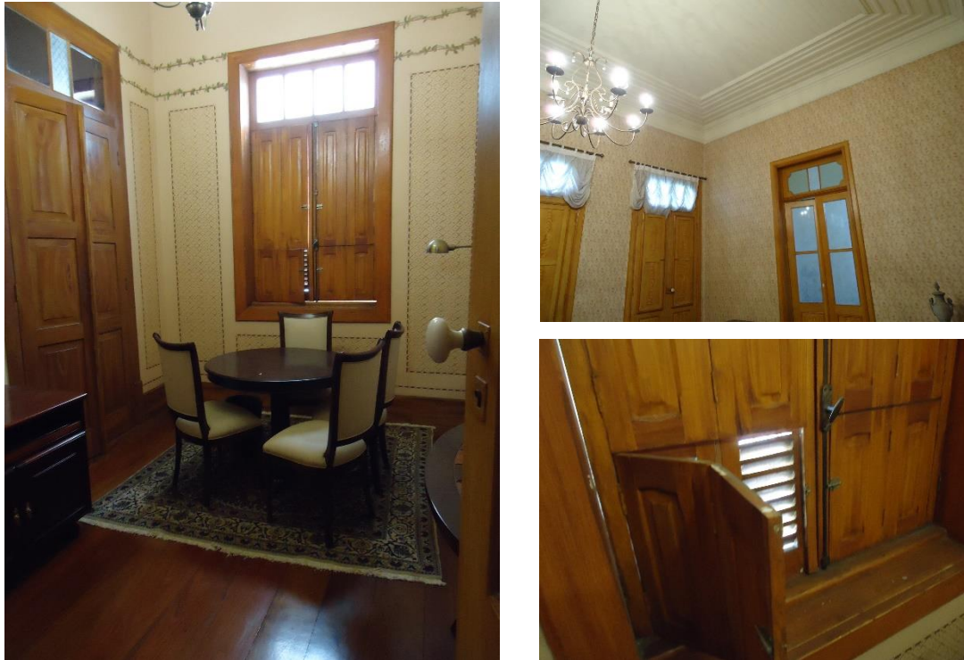
Figura 20: Vista das esquadrias em madeira do pavimento superior
