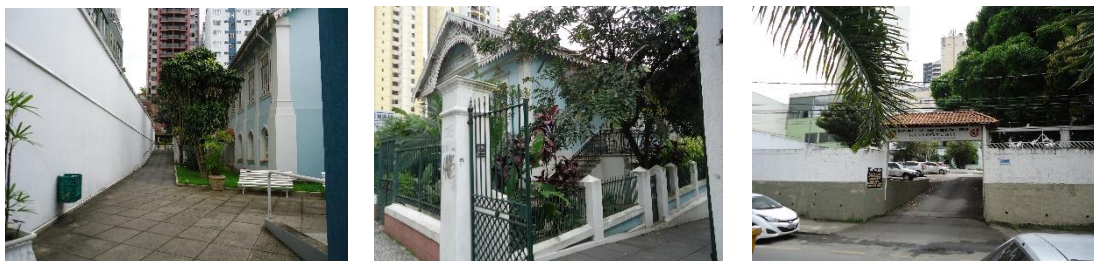
Figura 21: Vista do muro que delimita o terreno nas laterais (à direita), vista do gradil que delimita o terreno na sua parte frontal (ao centro), e vista do muro que delimita o acesso aos fundos do terreno (à direita)
