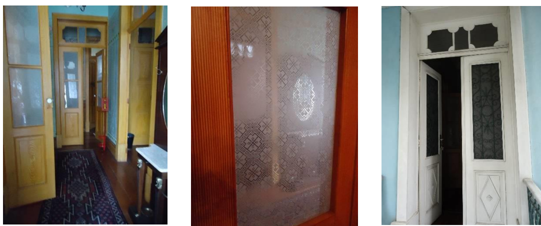
Figura 19: Detalhe das portas internas, com destaque para o desenho em um dos vidros, e vista da porta de acesso principal, todas do pavimento superior
