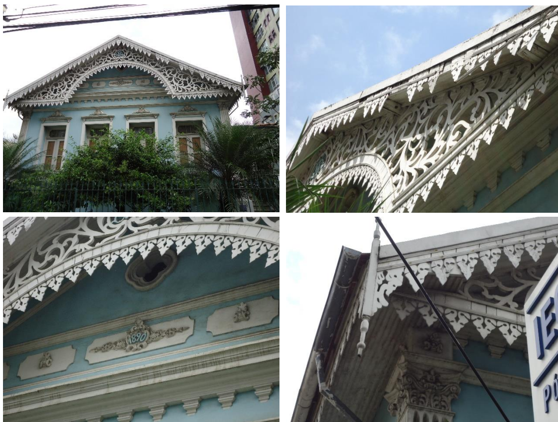
Figura 12: Detalhes da fachada frontal - Lambrequins, rendilhado de madeira, inscrição com a data de construção do prédio, beiral e colunas
