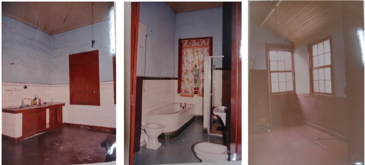
Figura 30: Vista da cozinha, banheiro e cômodo da área de serviços, em 1991
