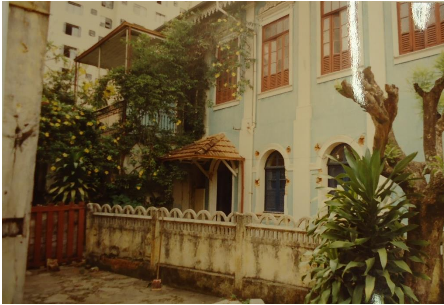
Figura 22: Vista da cerca que fazia a delimitação do terreno antes da última reforma, separando o acesso ao segundo pavimento, e o acesso ao pomar existente nos fundos do terreno
