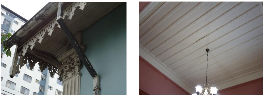
Figura 15: Detalhe do guarda-pó (à esquerda) e vista do forro de madeira de um dos cômodos do pavimento superior (à direita)
