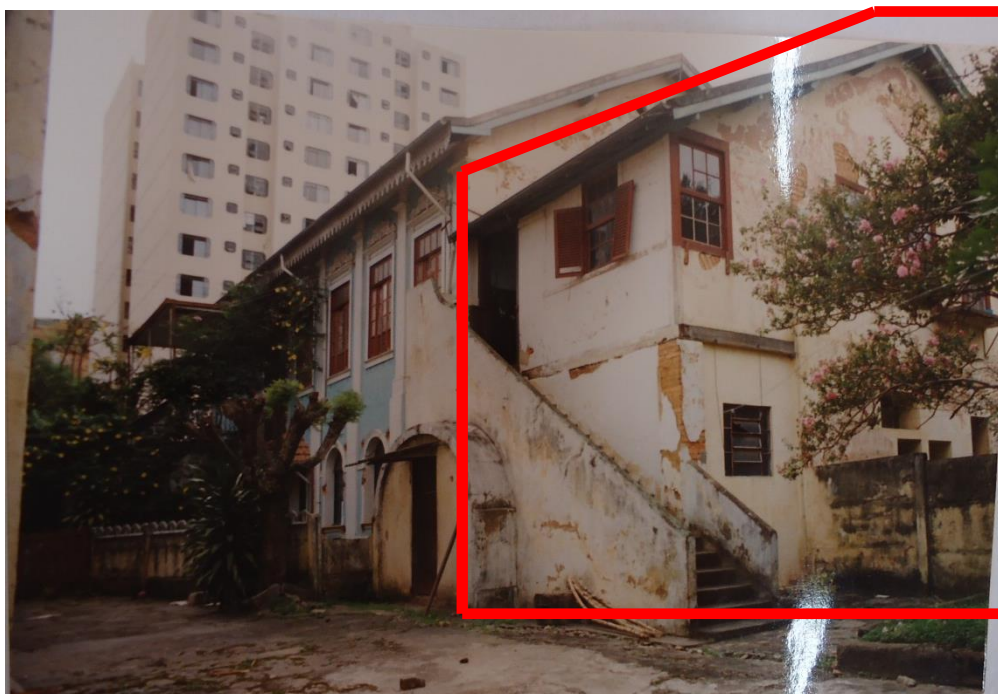
Figura 27: Foto de fevereiro de 1991, destacando em vermelho o anexo de serviços que foi desincorporado do perímetro de tombamento, e demolido
