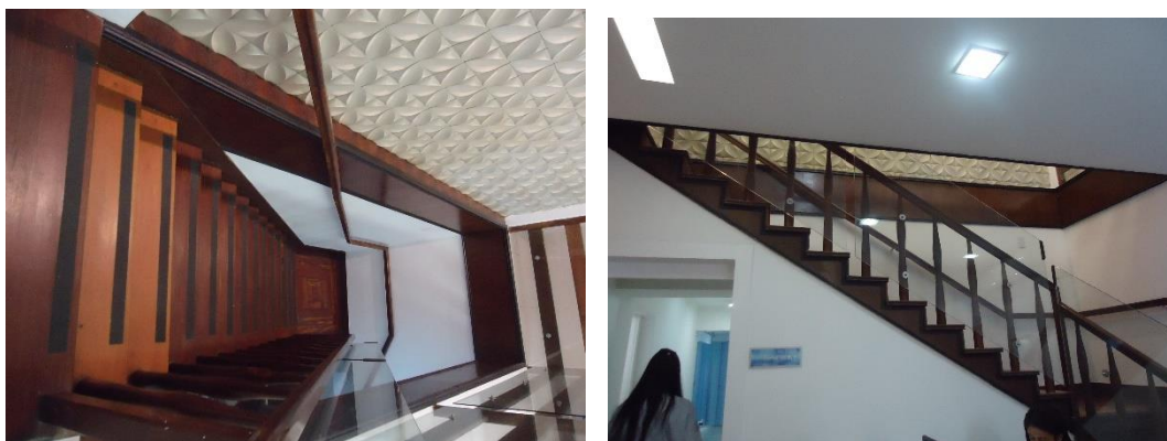
Figura 59: Vista da escada de madeira interna
