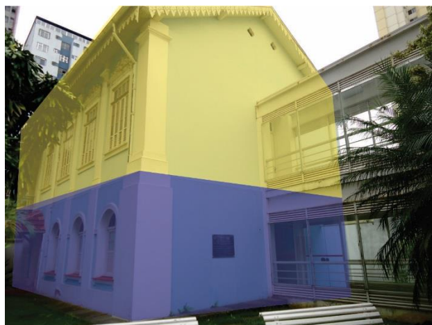
Figura 8: Esquema mostrando os dois volumes do Chalé. Em amarelo, o volume superior por onde se dá o acesso principal e em azul, o volume inferior.
