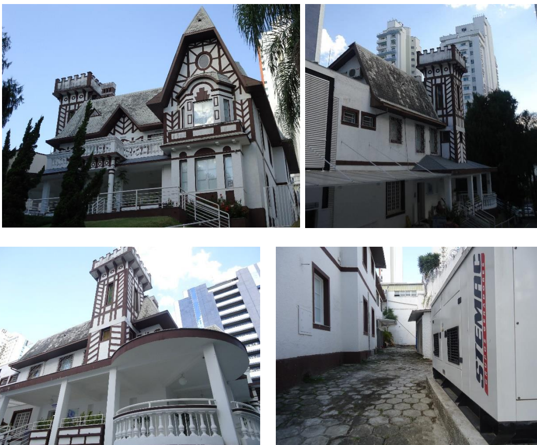
Figura 50: Detalhes da fachada frontal (à esquerda), com destaque para a varanda de acesso principal e um dos torreões; e detalhes das fachadas laterais, com as aberturas em formato retangular, destacando a presença de elementos que foram inseridos posteriormente, como os gradis nas janelas e uma cobertura em policarbonato
