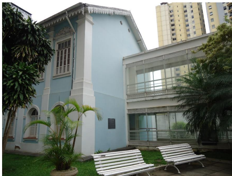
Figura 32: Vista atual da parte posterior do Chalé, após a demolição da área de serviços e a construção da passarela que dá acesso ao prédio anexo
