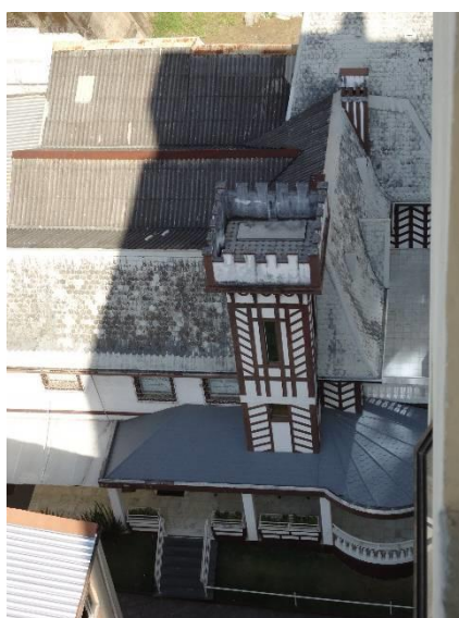
Figura 52: Vista do telhado do Castelinho
