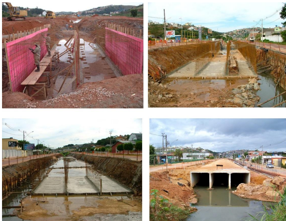
Figura 62: Processo de canalização do Córrego São Pedro. Fonte: acessa.com
