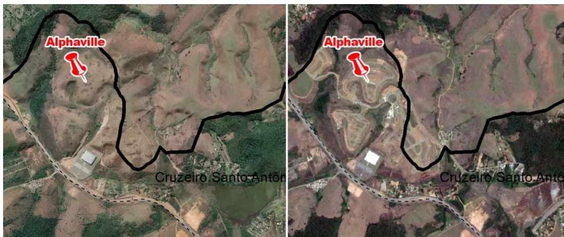
Figura 44: Local de instalação do Complexo Residencial Alphaville Juiz de Fora.
