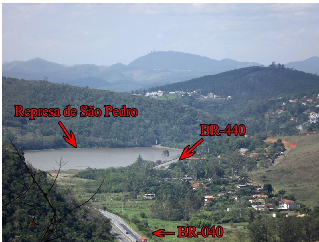
Figura 65: Vista panorâmica da Represa São Pedro, BR-040 e trecho final das obras da BR-440. Na imagem é possível perceber a proximidade da nova rodovia com o manancial. Fonte: do autor.
