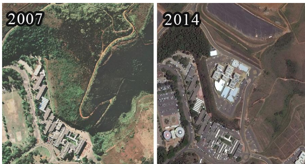
Figura 79: Crescimento Urbano observado nas dependências da UFJF entre os anos de 2007 e 2014.
