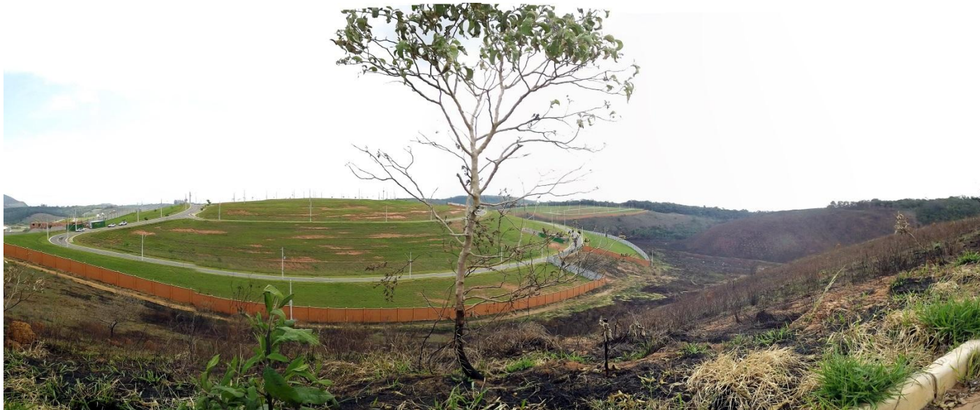
Figura 46: Um muro faz a delimitação da área do empreendimento Foto do Autor (21/09/2016).
