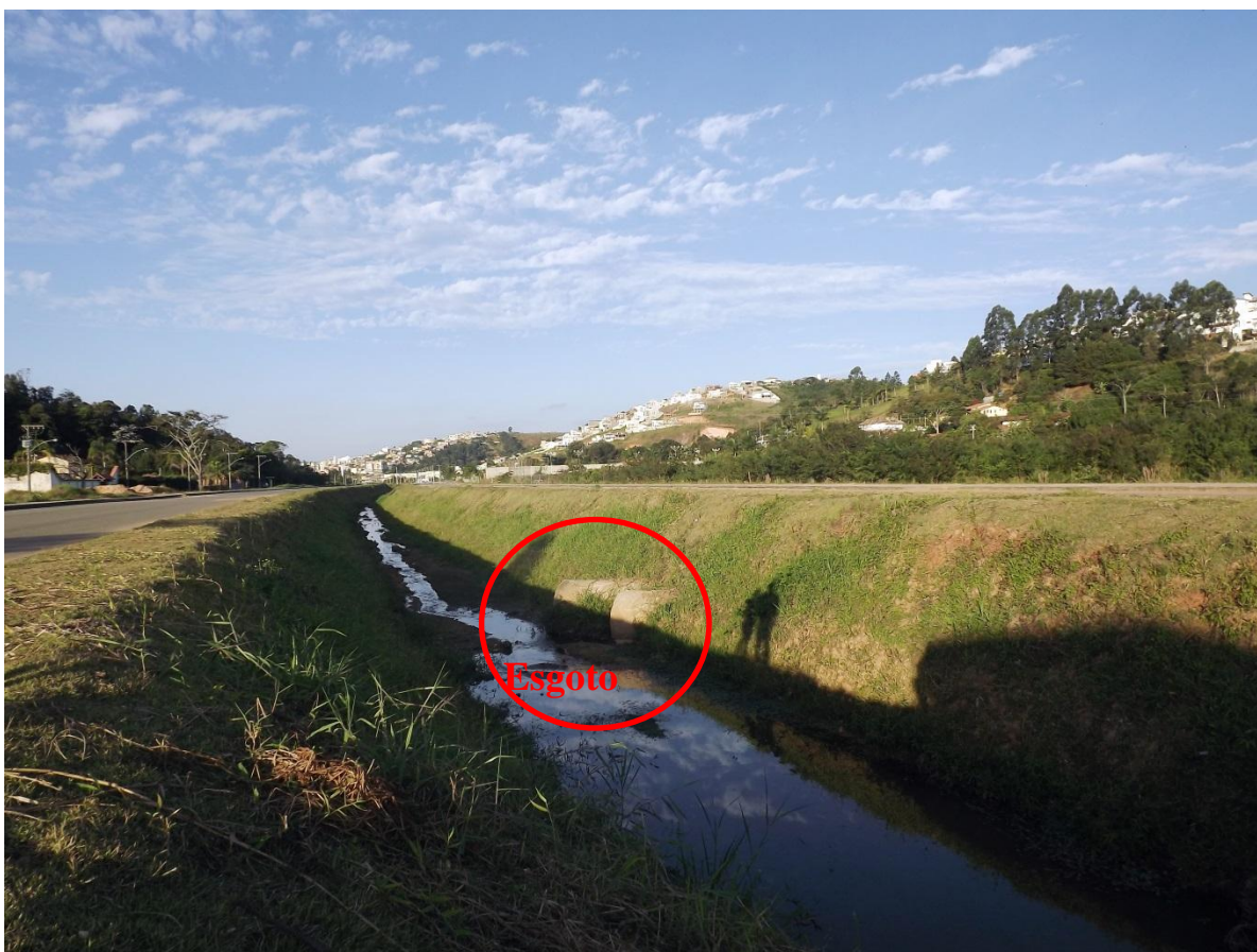
Figura 57: Trecho não canalizado do Córrego São Pedro em que é possível observar o lançamento de esgoto in natura na drenagem. Fonte: do autor.
