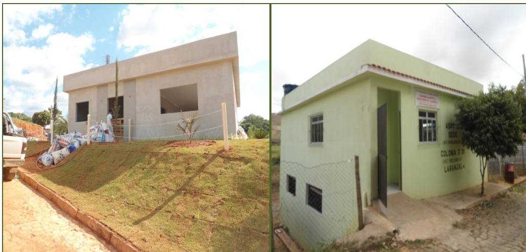
Figura 9 - Vista da sede da APEDI em Itaperuçu (Palma-MG) e da ASPPAQ, em Laranjal-MG, respectivamente.
