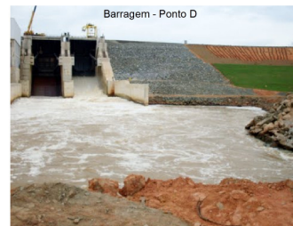
Barragem - Ponto D
