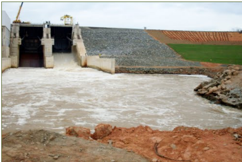
Figura 8 - Vista da Barragem e das comportas
