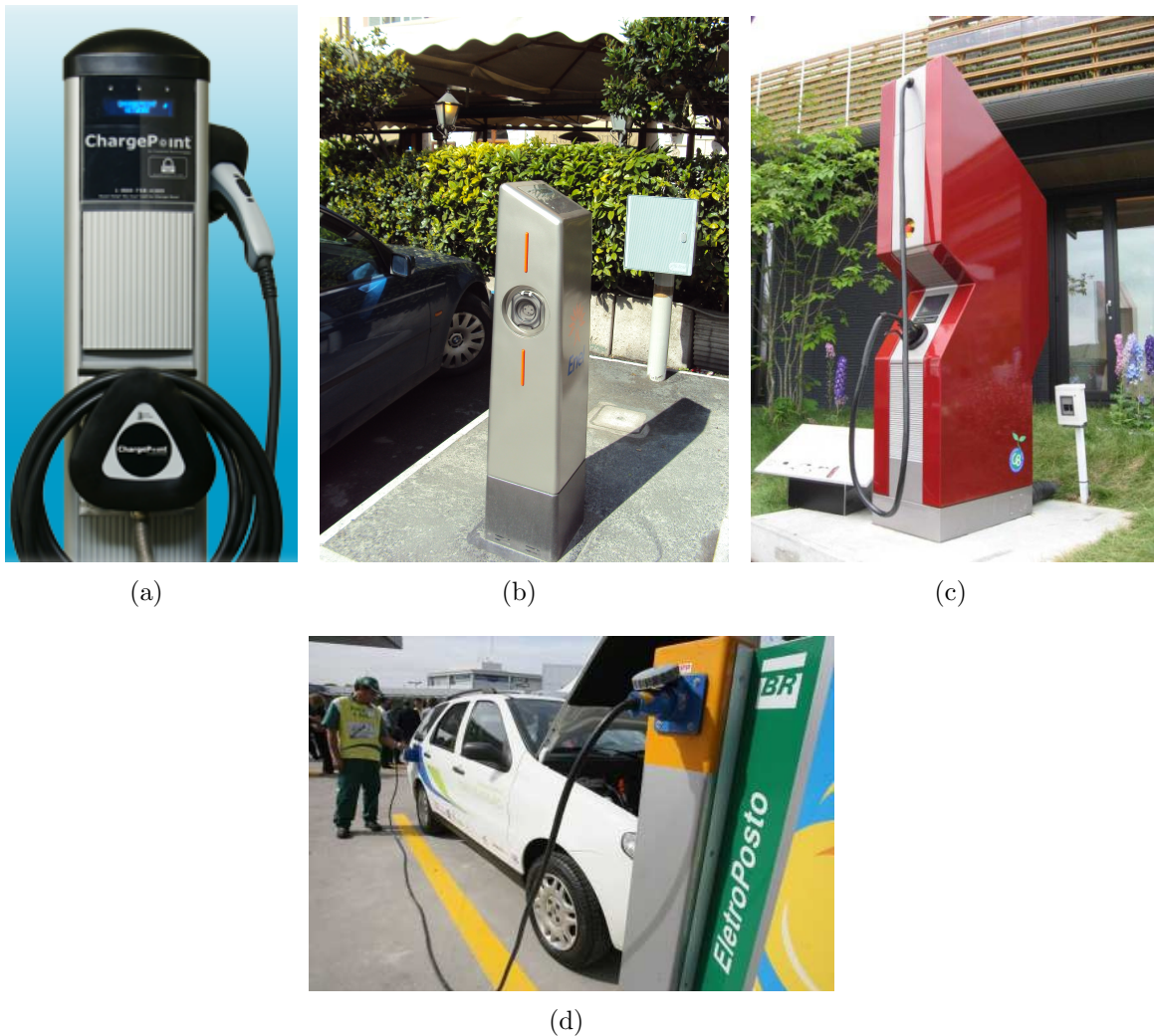
Figura 41: Exemplos de infraestrutura de recarga para VEs. (a) Ponto de recarga residencial, EUA (fonte: www.chargepoint.com ); (b) Ponto de recarga em estacionamento em via pública, Roma, Itália. (c) Estação de recarga rápida, Tóquio, Japão (fonte: (ANEGAWA, 2008)); (d) Ponto de recarga lenta Petrobras/MotorZ, Rio de Janeiro (fonte: www.abve.org.br ).
