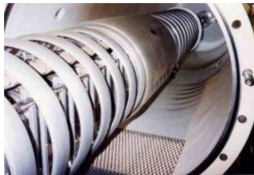
Figura 3.9: Vista do interior do acelerador. No centro, temos o terminal.
