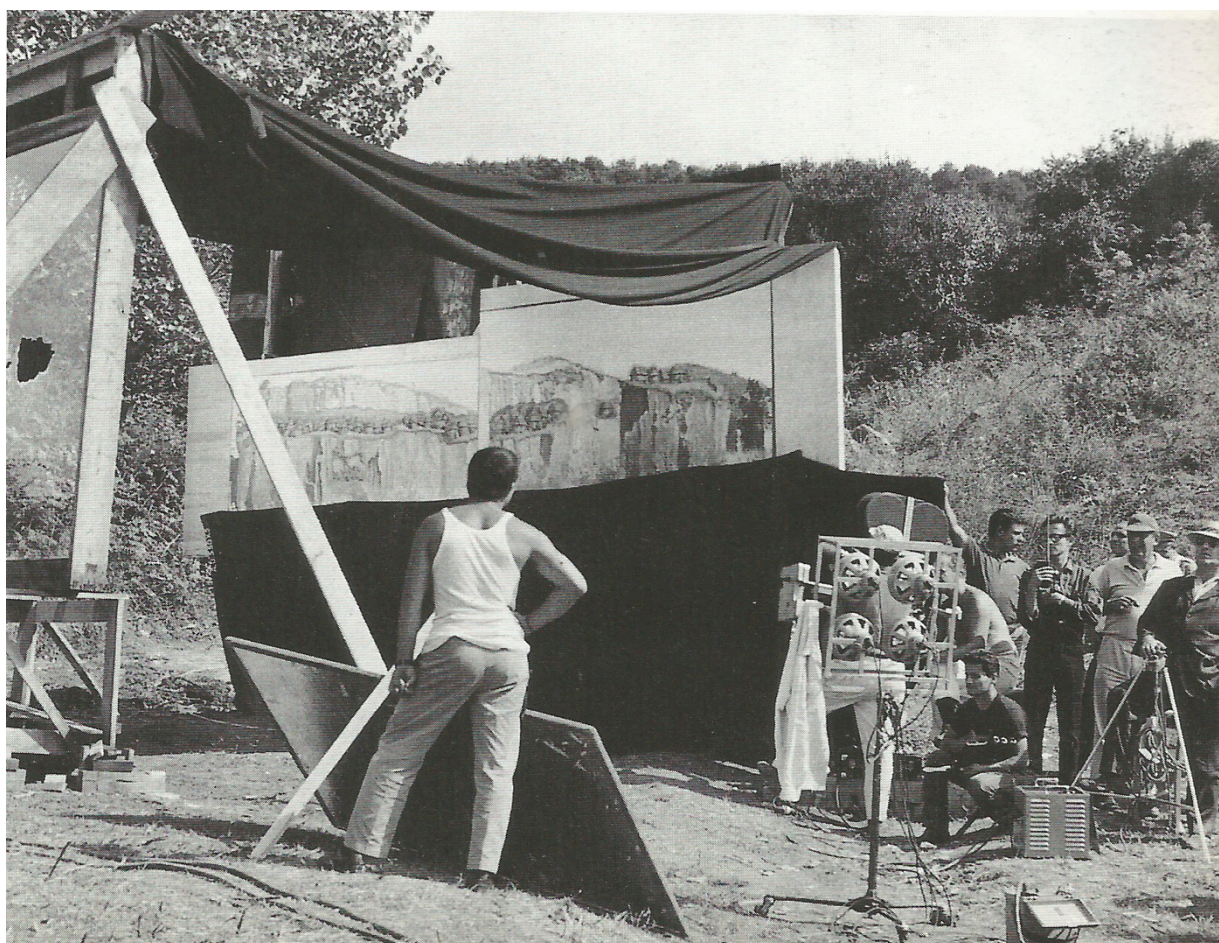
10. Filmagens do efeito schufftan em Idade do Ferro . O painel era montado atrás da câmera e refletido em um vidro que ficava em frente a ela.
