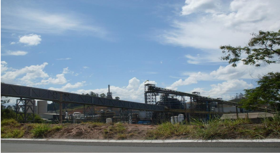
Figura 12: Vista parcial da tubulação de rejeitos industriais da Votorantim Metais. Foto tirada a partir da BR-267, em 14/09/2010, (autora).
