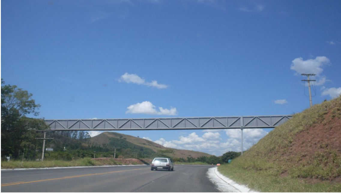
Figura 10: Vista parcial da tubulação de rejeitos industriais da Votorantim Metais. Foto tirada a partir da BR-267, em 14/09/2010, (autora).
