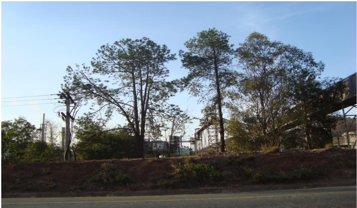
Figura 11: Vista parcial da tubulação de rejeitos industriais da Votorantim Metais. Foto tirada a partir da BR-267, em 14/09/2010, (autora).
