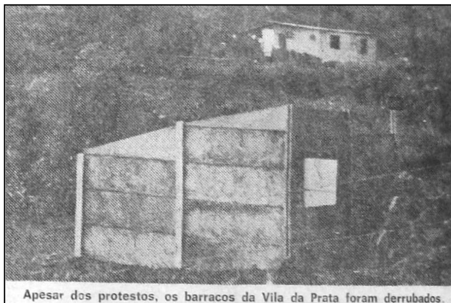
Fotografia 4 – Demolição de moradias na antiga Vila da Prata, em junho de 1978.
