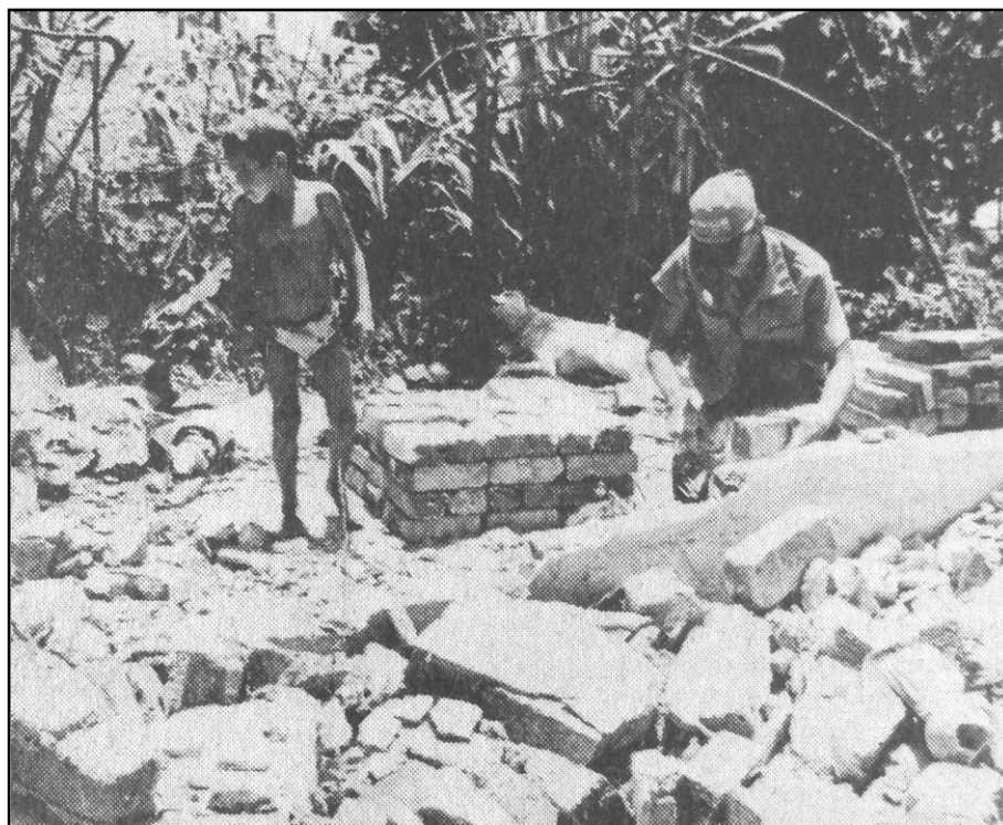
Fotografia 10 - Moradores em meio aos escombros, no dia 24 de dezembro de 1981, dois dias depois da destruição da antiga Vila da Prata.
