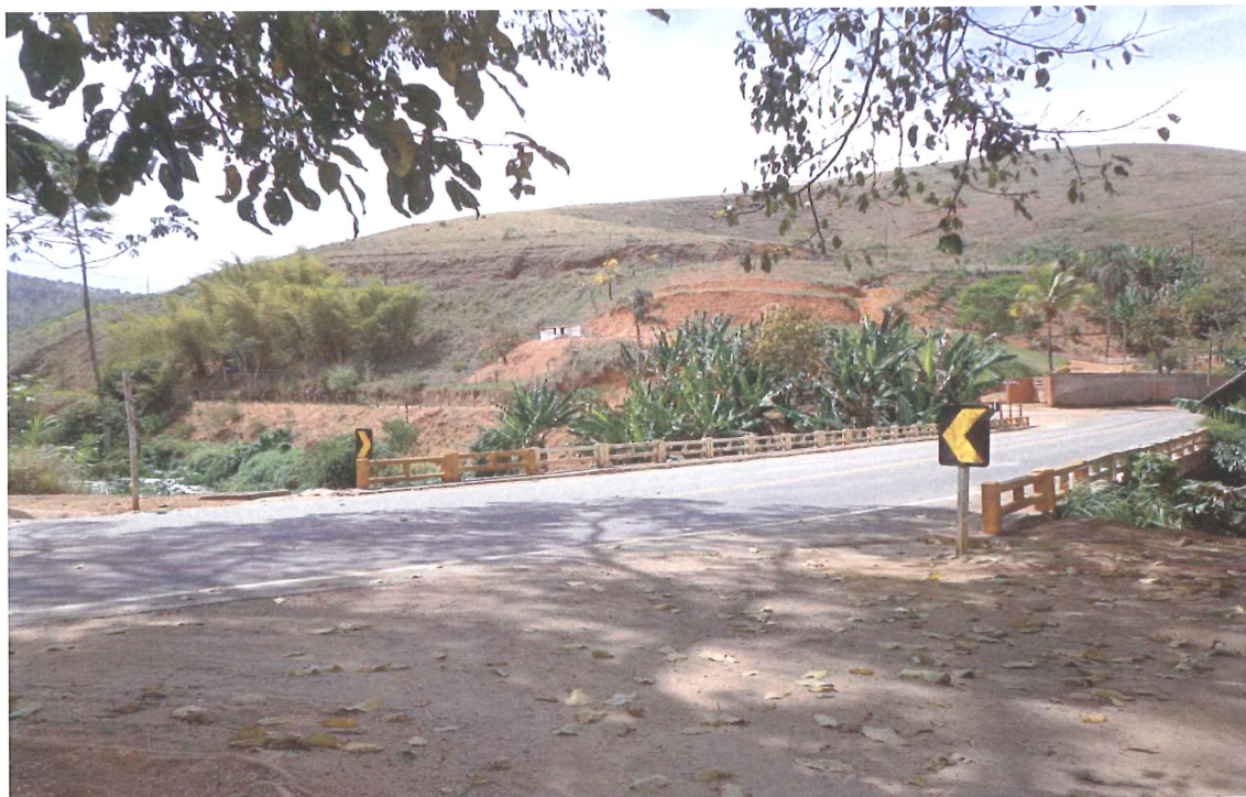
FIGURA 24 – Ponte do Zamba vista da margem direita do Paraibuna com a entrada do Joazal a Esquerda após a ponte. (Foto de Elizandra Ferreira Dias, 2013)
