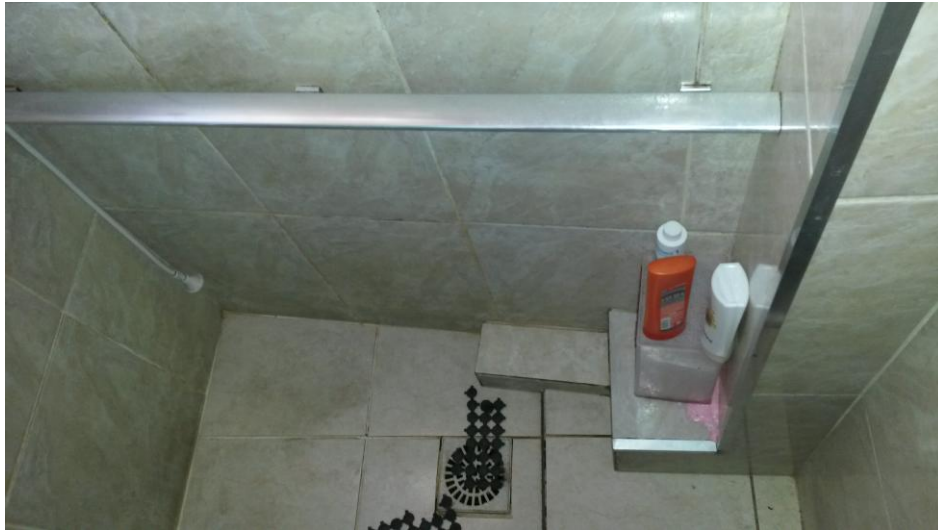
Figura 14- Box do banheiro - domicílio A 12 Fonte: Acervo da autora, 2015
