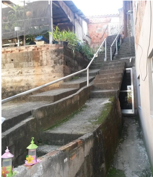
Figura 16 - Escada de acesso - queda varrendo - domicílio J Fonte: Acervo da autora, 2015
