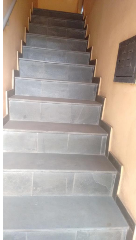
Figura 26 - Escada de acesso a casa - domicílio B Fonte: Acervo da autora, 2015
