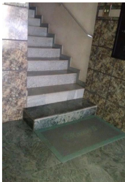
Figura 36 - Piso escada/hall - domicílio G Fonte: Acervo da autora, 2015
