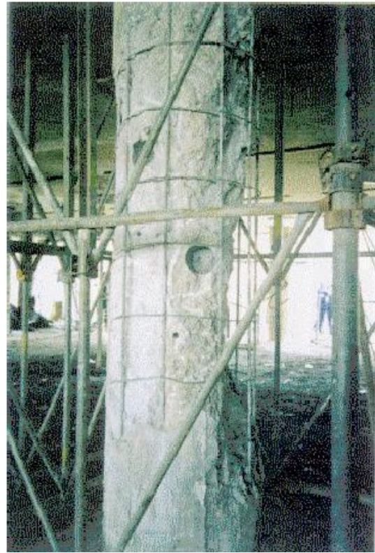
(b) Pilar atingido pelo incêndio no Aeroporto Santos Dumont, Rio de Janeiro, 1998.
