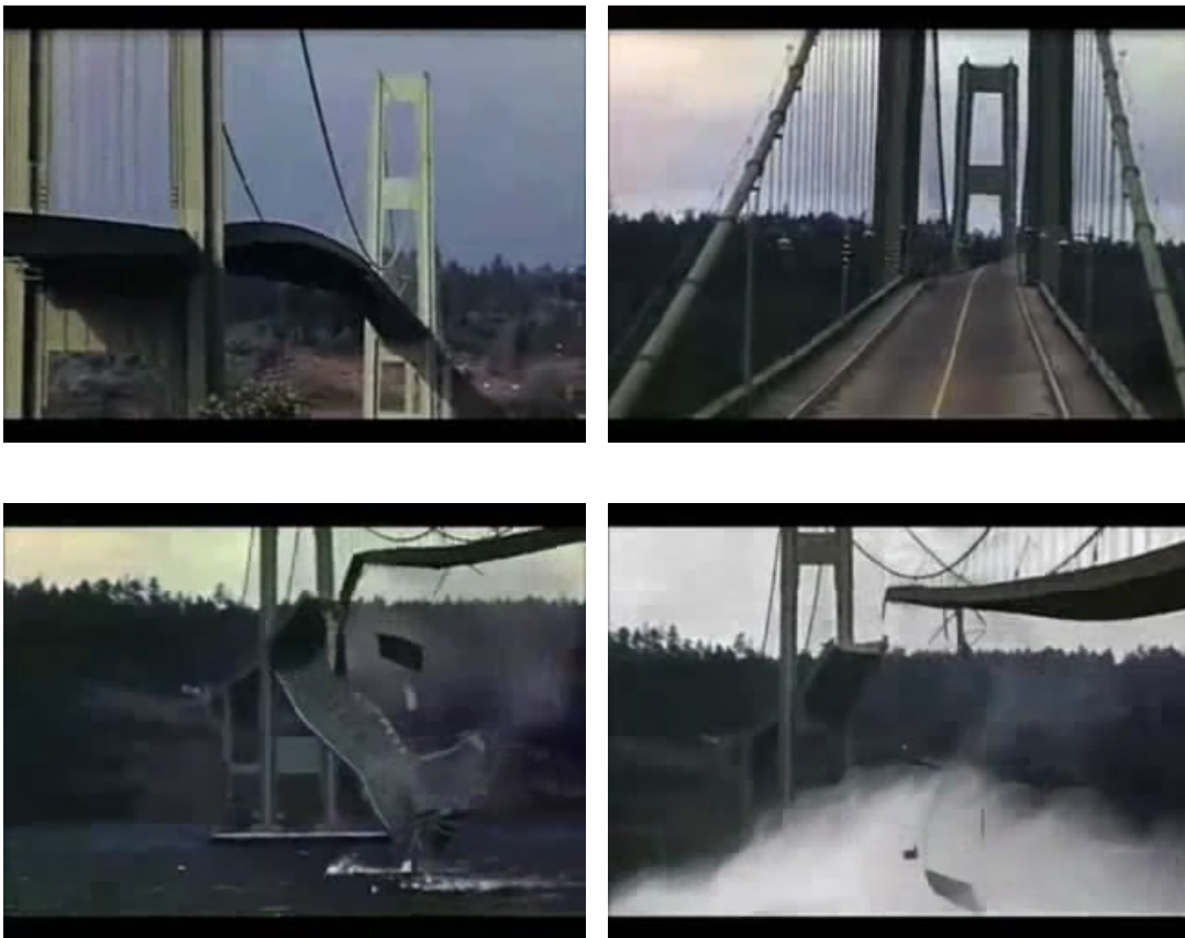
Figura 1.1: Ponte de Tacoma Narrows durante o colapso.
