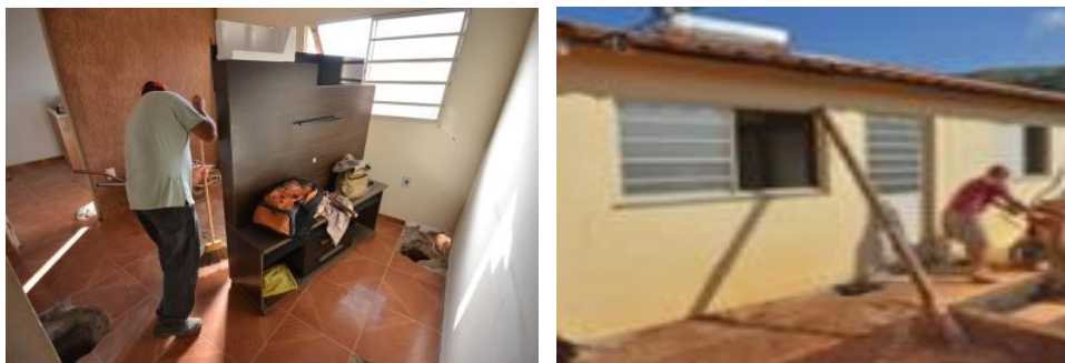
Interior das casas também precisou de reparos
