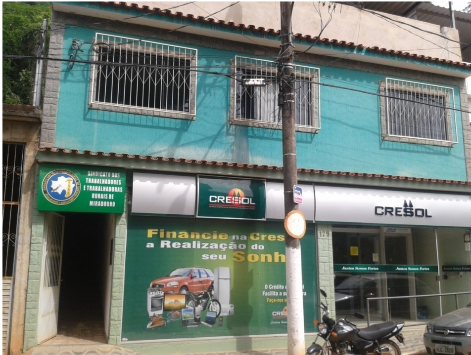
FOTO 3 – Sindicato dos Trabalhadores Rurais de Miradouro
