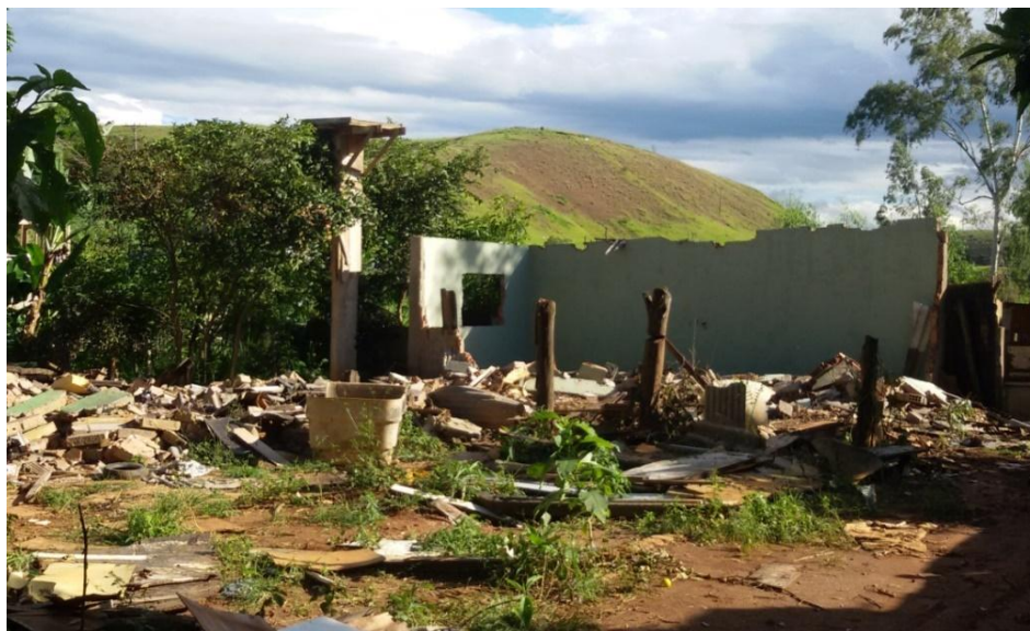
Figura 17 – Casa demolida no dia da remoção
