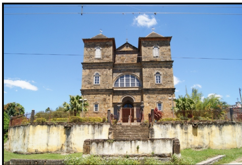
Figura 8 - Igreja católica de São José das Três Ilhas, construída por iniciativa do Barão de São José Del Rey por ocasião do casamento de sua filha.
