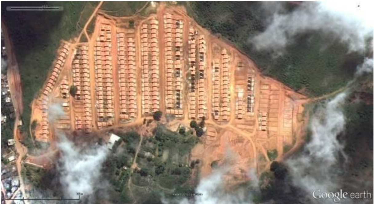
Figura 37 - Fotografia da fase de construção do CH5. Data da imagem: 05/09/2011
