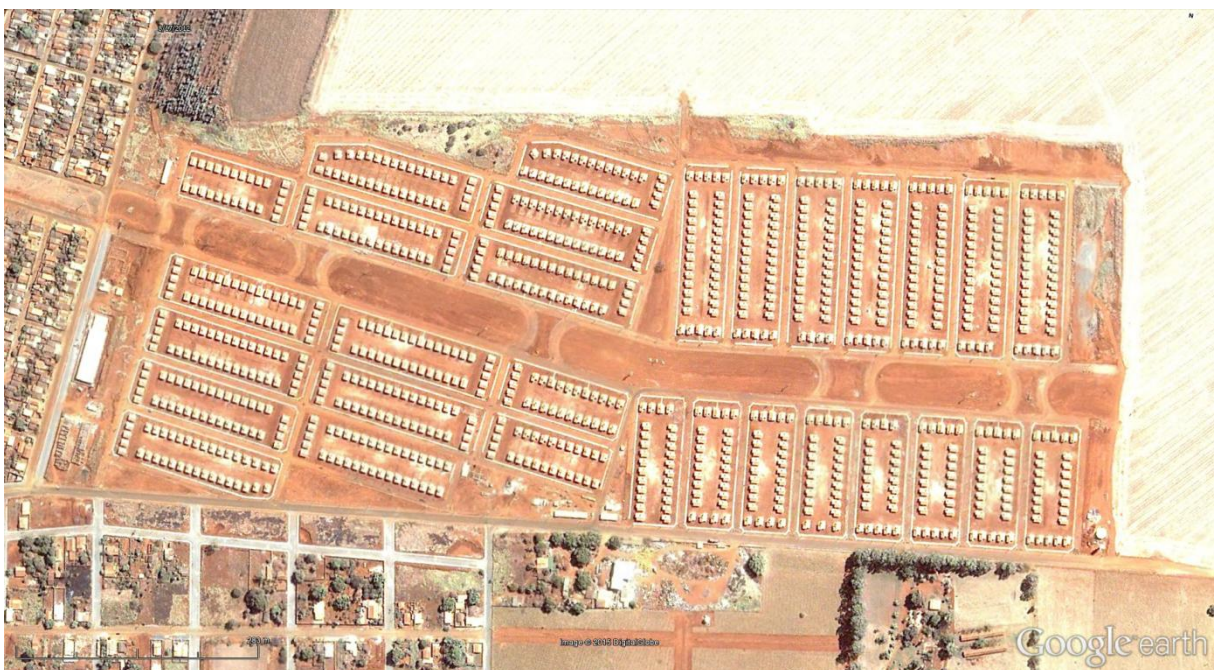
Figura 29 - Fotografia da fase de construção do CH3. Data da imagem: 17/08/2012
