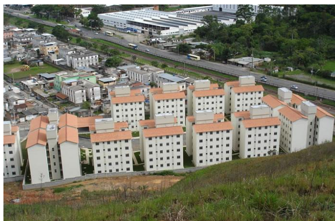
Figura 16 - Residencial Belo Vale I - Tipologia multifamiliar: edifícios de apartamentos
