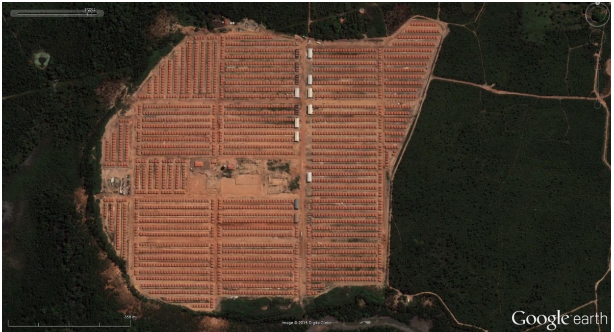
Figura 25 - Fotografia da fase de construção do CH2. Data da imagem: 4/08/2011
