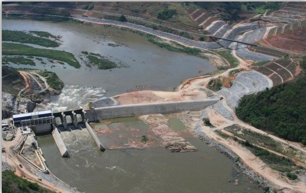
Figura 2: Barragem de Anta (fonte: Eletrobrás Furnas)
