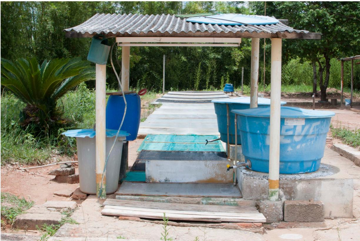
Figura 06: Pequena estação de tratamento de água.
