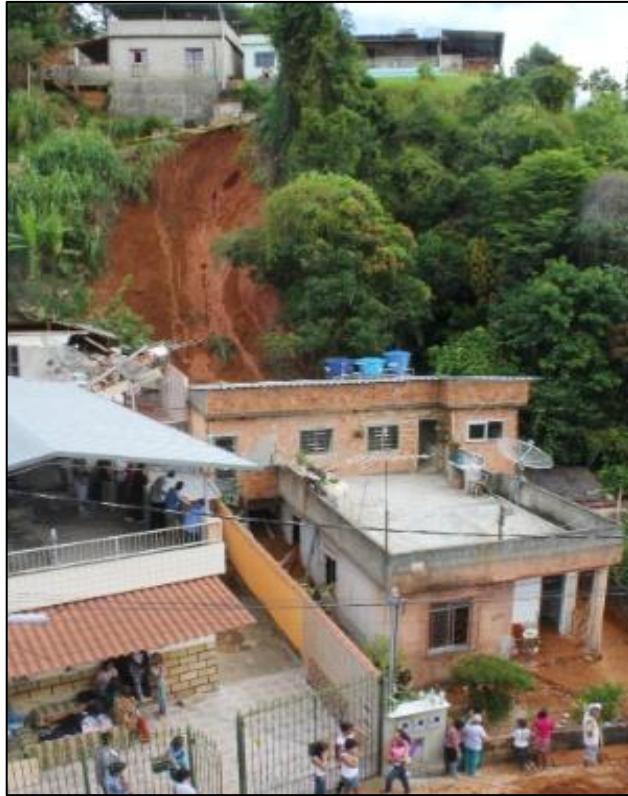
Foto 10: Deslizamento de terra ocorrido no ano de 2012. Fonte: Acessa.com
