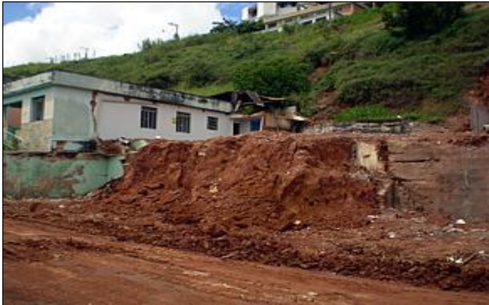
Foto 12: Deslizamento no bairro Santa Tereza em 2011. Fonte: Tribuna de Minas.
