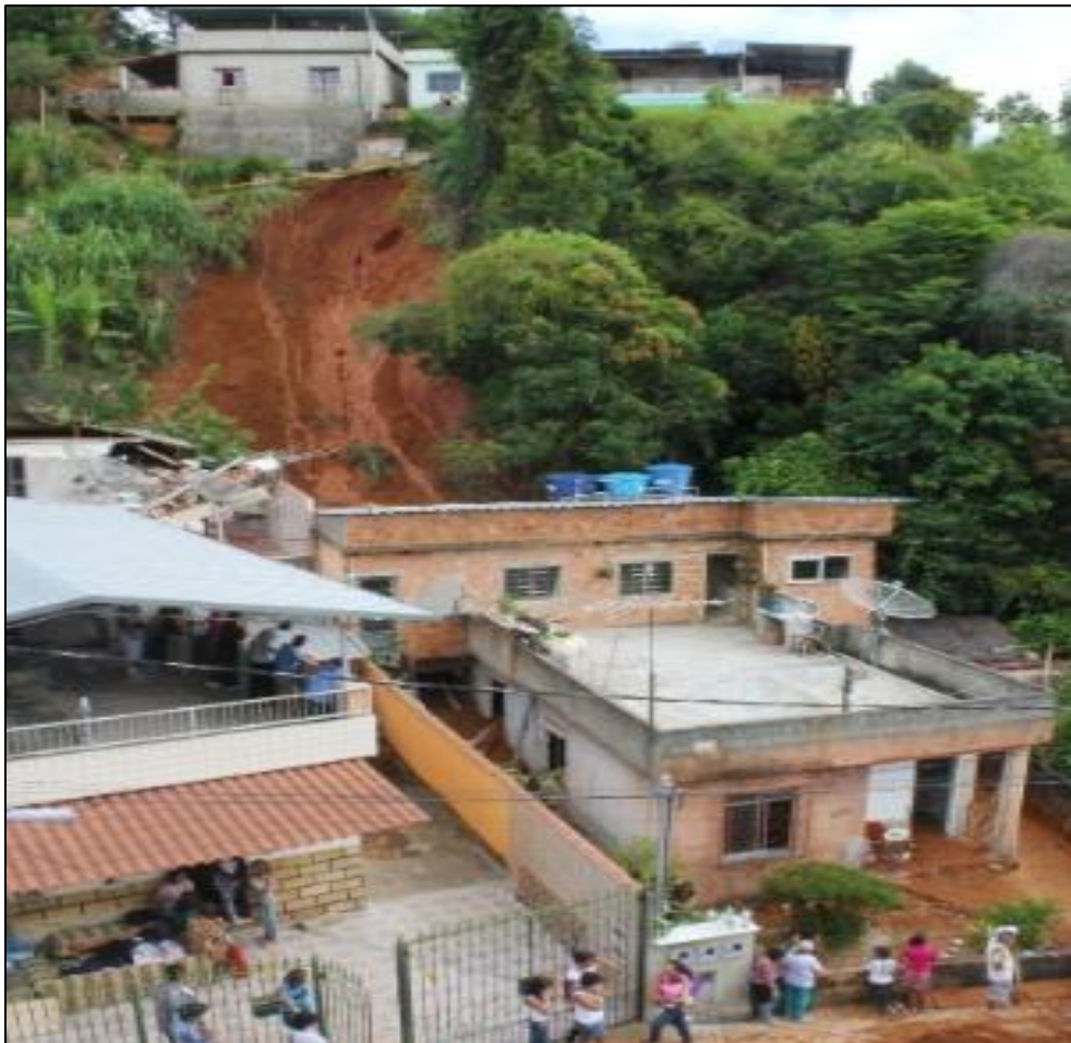
Foto 5: Deslizamento ocorrido no bairro Linhares em 2012. Fonte: UOL.
