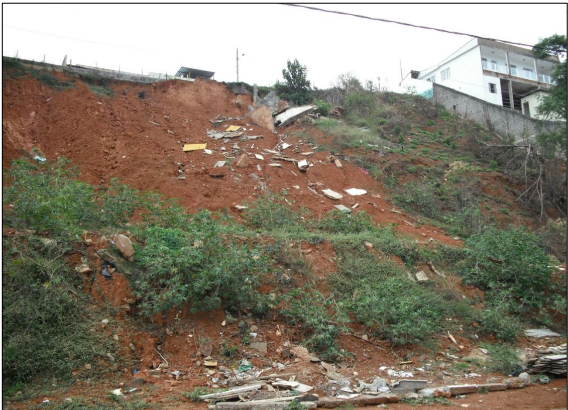
Foto 3: Deslizamento no bairro Santa Luzia no ano de 2012. Fonte: Acervo pessoal
