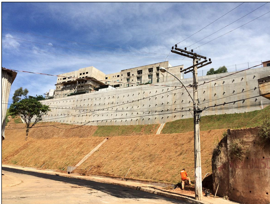
Foto 13: Muro de contenção terminado no ano de 2014, no bairro Santa Tereza. Fonte: Prefeitura Municipal de Juiz de Fora.
