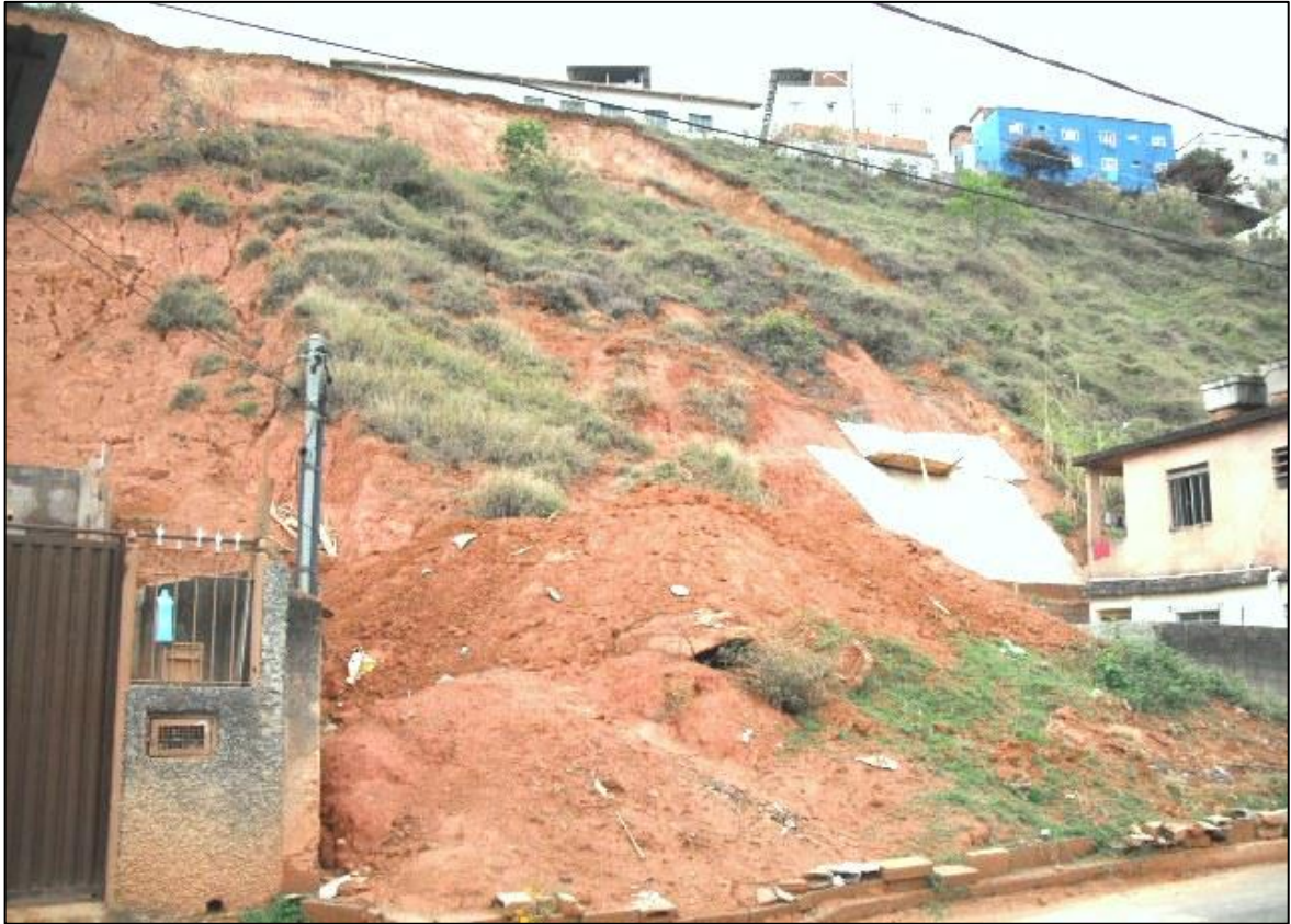
Foto 2: Deslizamento no bairro Santa Luzia em 2011. Fonte: Acervo pessoal.
