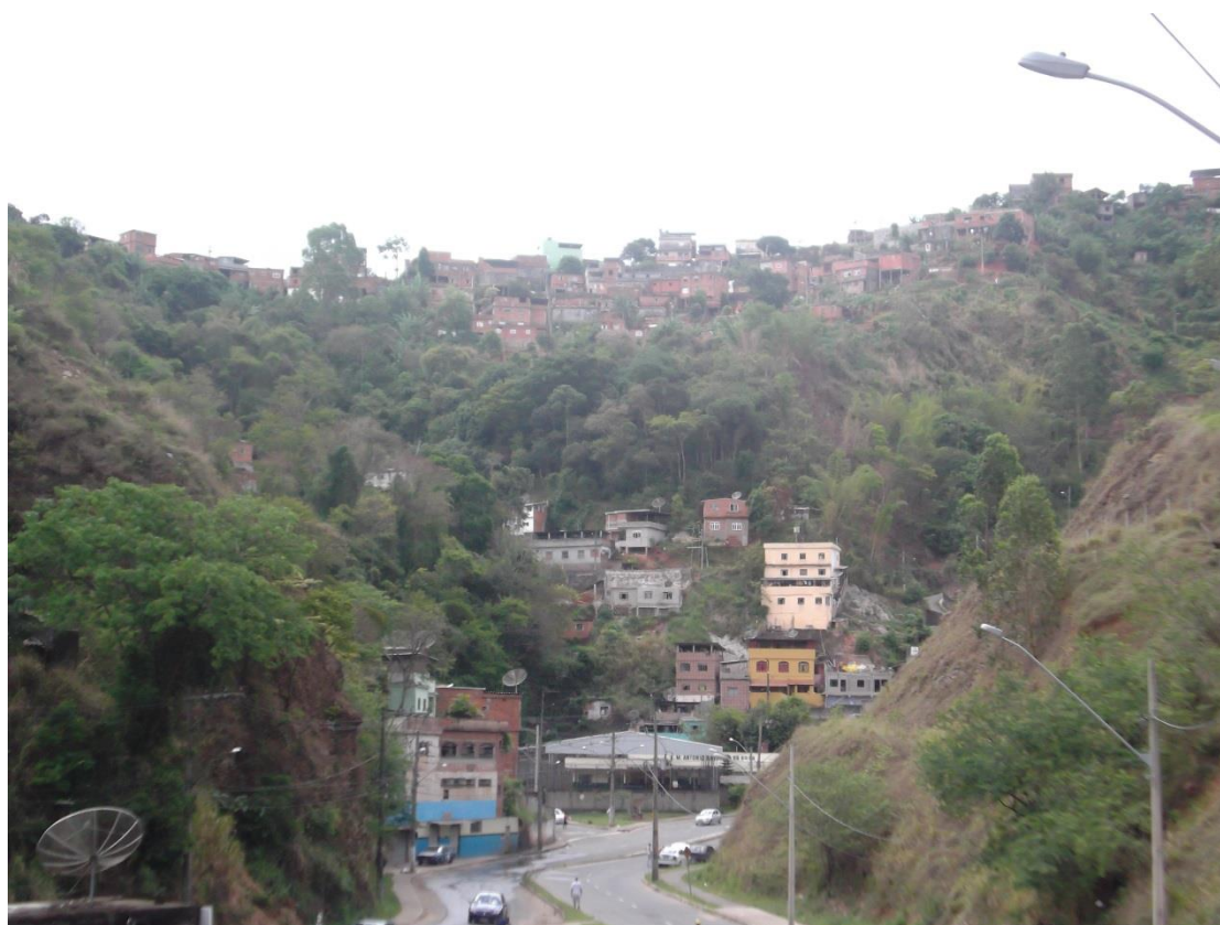
Figura 52: Ocupações de Imóveis em áreas de alta instabilidade à instáveis.
