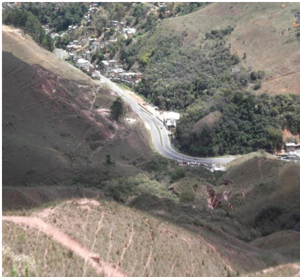
Figura 11: Avenida por onde passa o canal principal do Córrego do Yung
