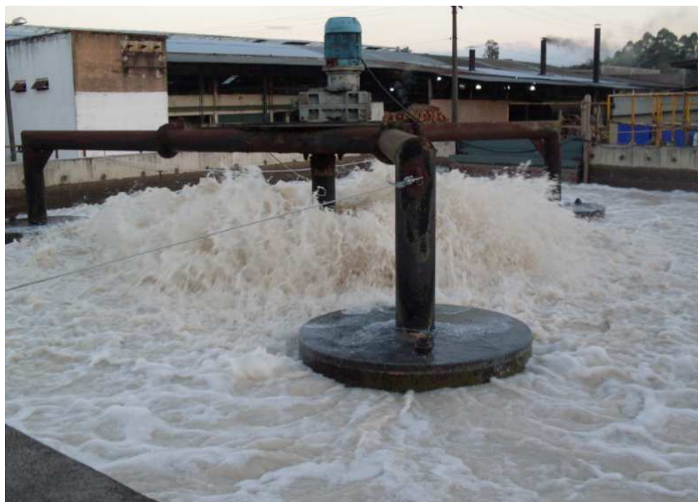
Figura 4.1 – Tanque de equalização onde se coletou a ARL aplicada nos SACs.
