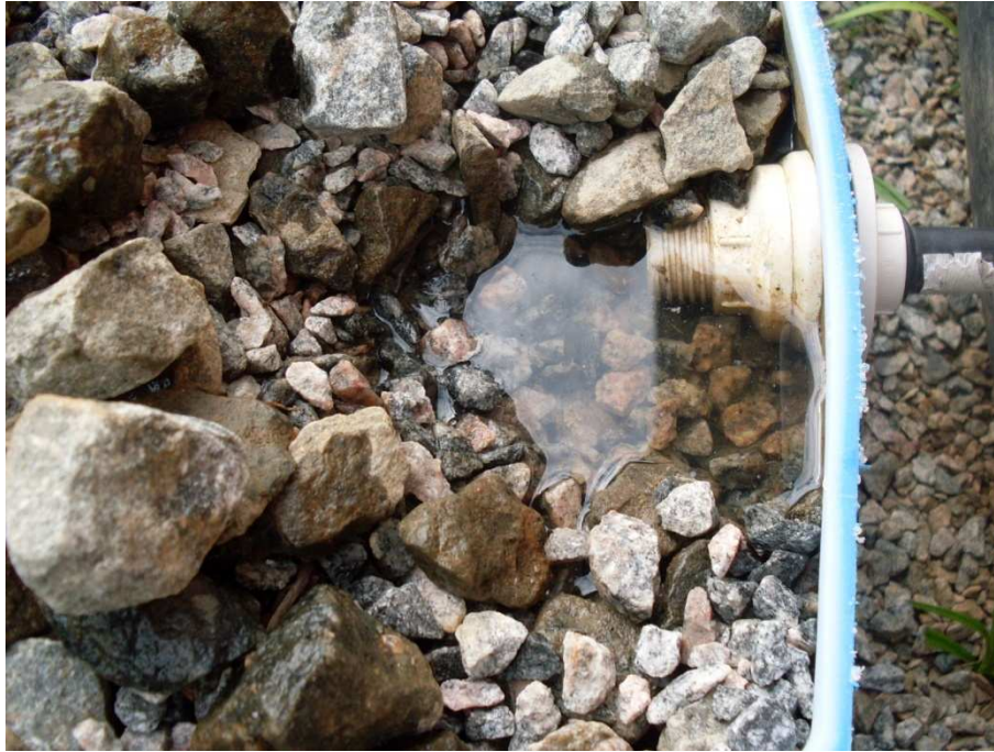
Figura III.3 – Detalhe da zona de saída do efluente tratado do SAC 1 no momento do início de um novo ciclo de 48 horas.
