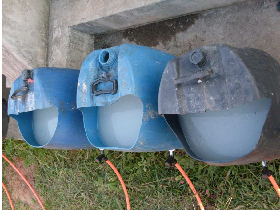
Figura III.5 – Reservatórios de distribuição da ARL.
