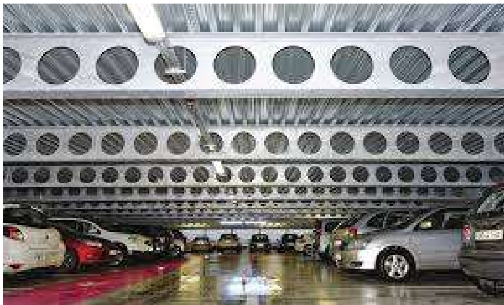
Figura 12 - Vigas celulares aplicadas em estacionamentos
