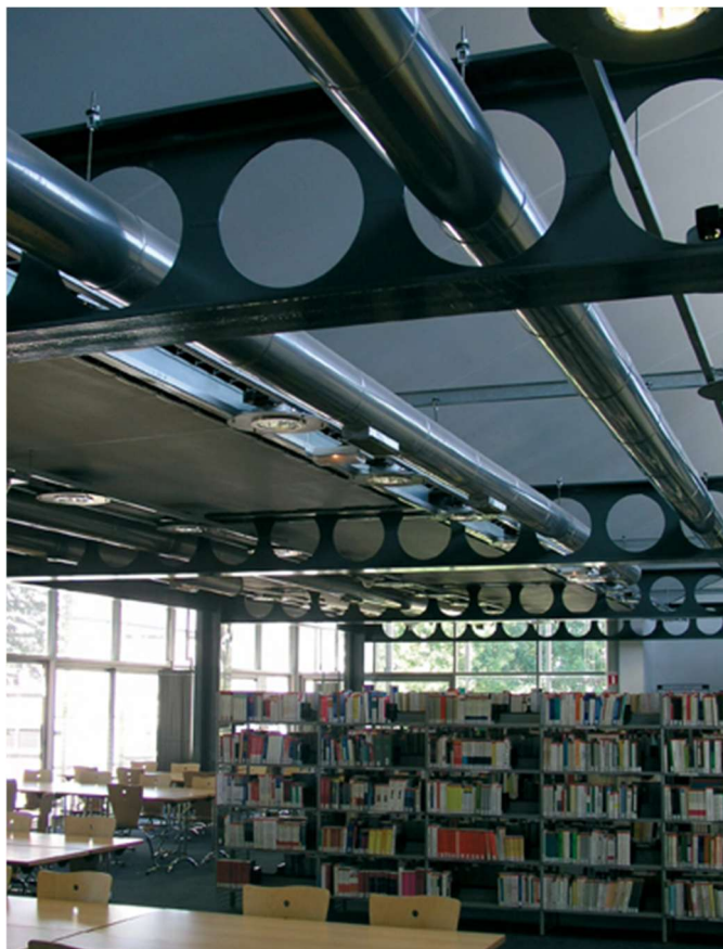
Figura 13 - Passagem de dutos pelos alvéolos
