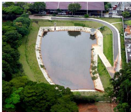
Figura 3 - Bacia de retenção.
