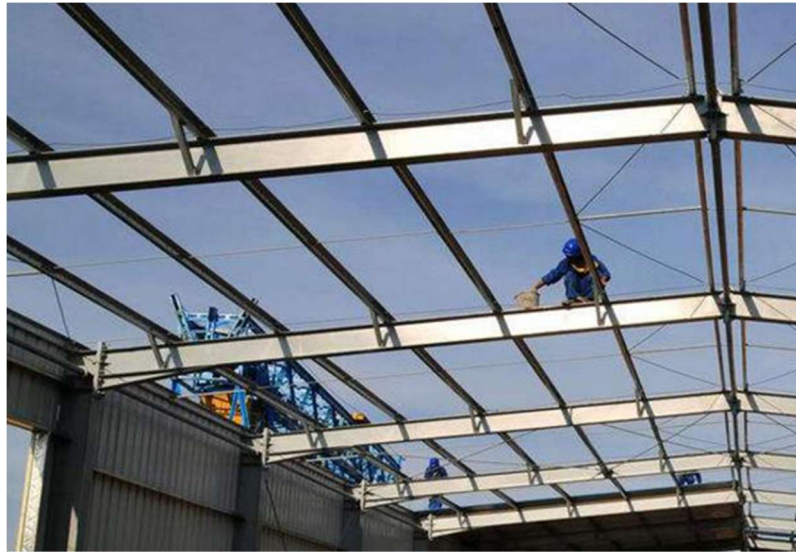
Figura 1 – Terça apoiada sobre tesouras em alma cheia
