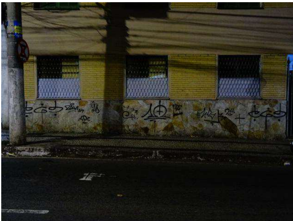
Figura 16 – Fachada, Avenida Barão do Rio Branco
