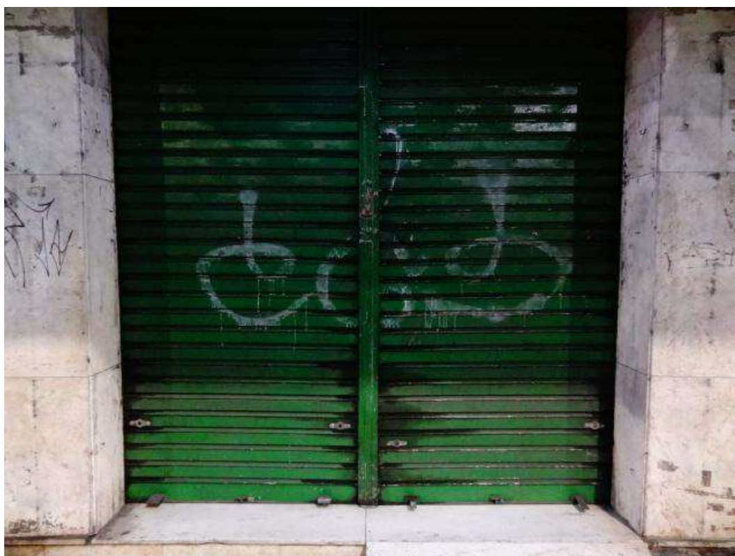
Figura 5 – Porta de Aço, Avenida Barão do Rio Branco
