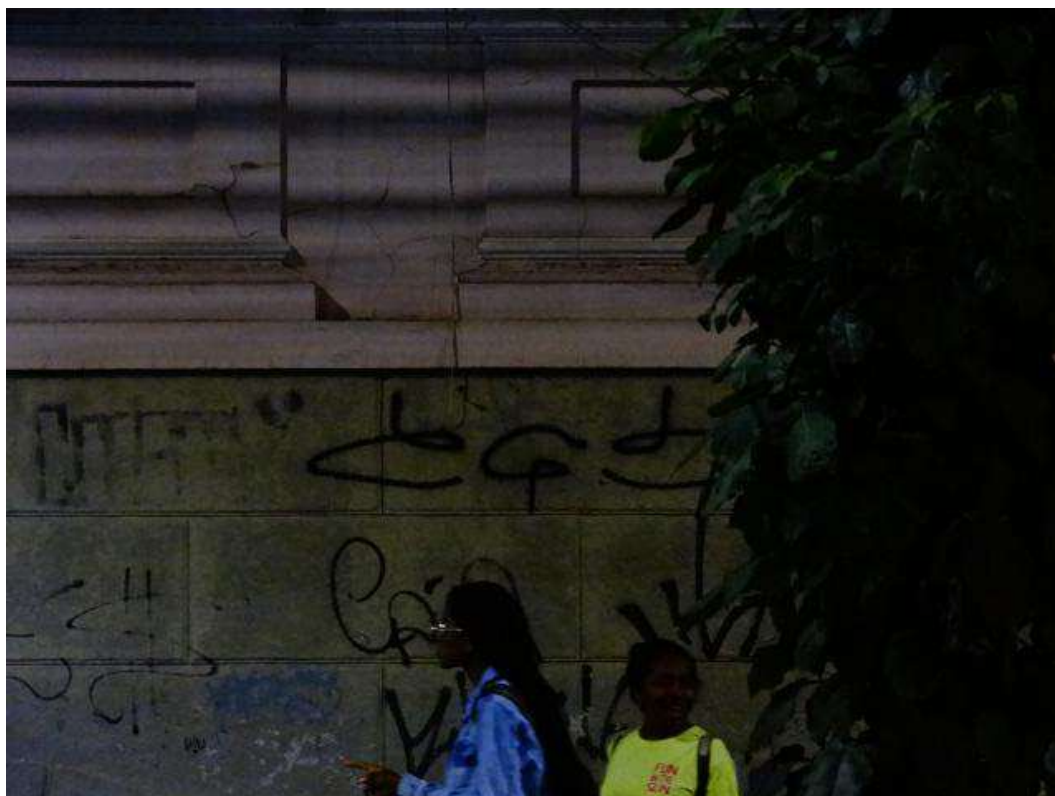
Figura 2 – HPS, Avenida Barão do Rio Branco
