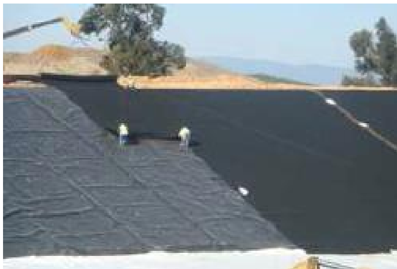
Figura 8 - Geomembrana em aterro sanitário
