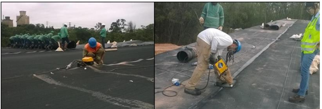
Figura 7 - Processo de instalação de geomembrana em aterro
