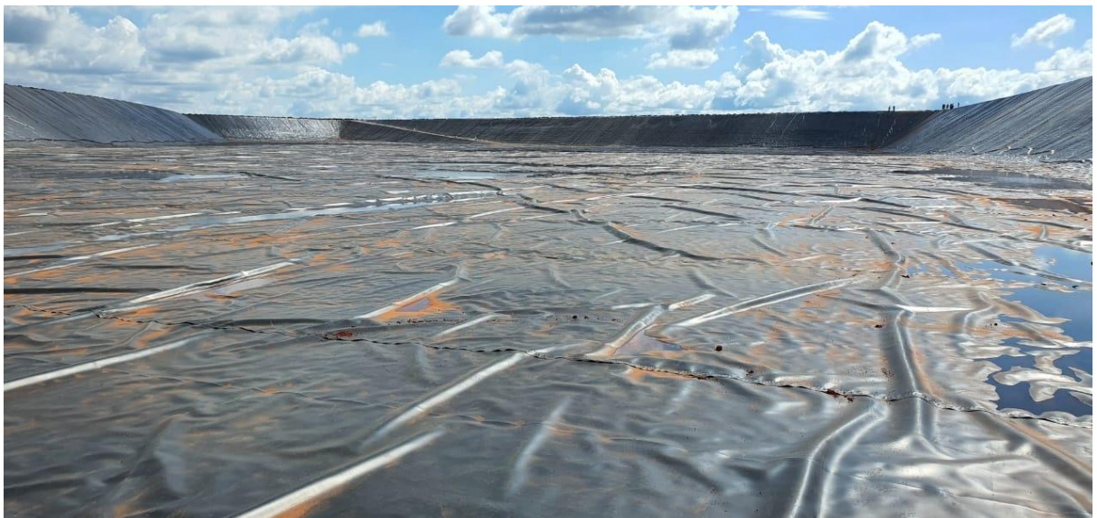
Figura 6 - Instalação de geomembrana
