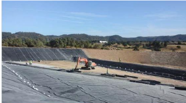
Figura 5 - Geomembrana em lagoa de armazenamento para irrigação
