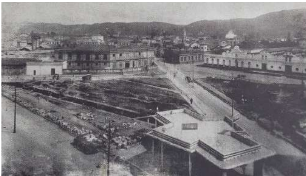
Figura 13 - Obra de construção da Praça Antônio Carlos em 1933
