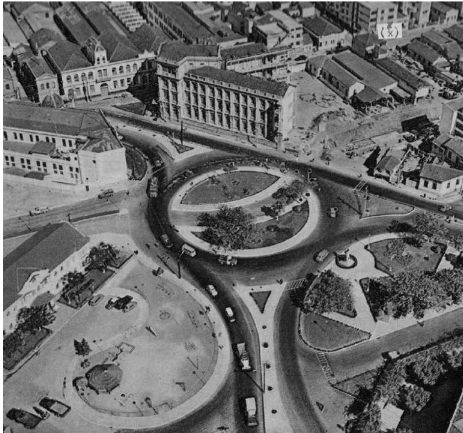
Figura 17 - Obras de abertura da Avenida Independência, com destaque para nova conformação do espaço da Praça Antônio Carlos, no final da década de 1960
