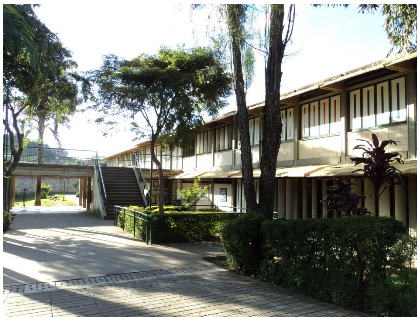
Figura 66: Entrada principal - Escola Municipal Núbia Pereira Magalhães (Fonte: a autora)
