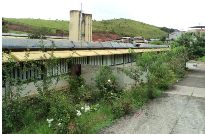
Figura 91: Vista dos sheds de iluminação (Fonte: a autora, março/2015)
