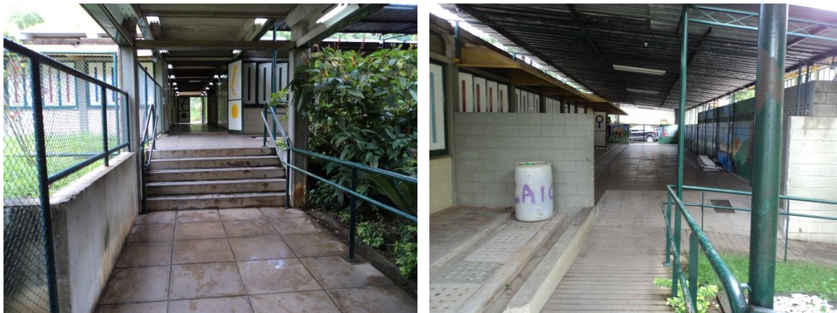
Figura 87: Ligação entre os prédios (Fonte a autora, março/2015)
