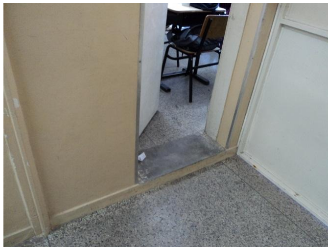
Figura 39: Desnível existente na entrada das salas de aula (Fonte: a autora, out/2014)
