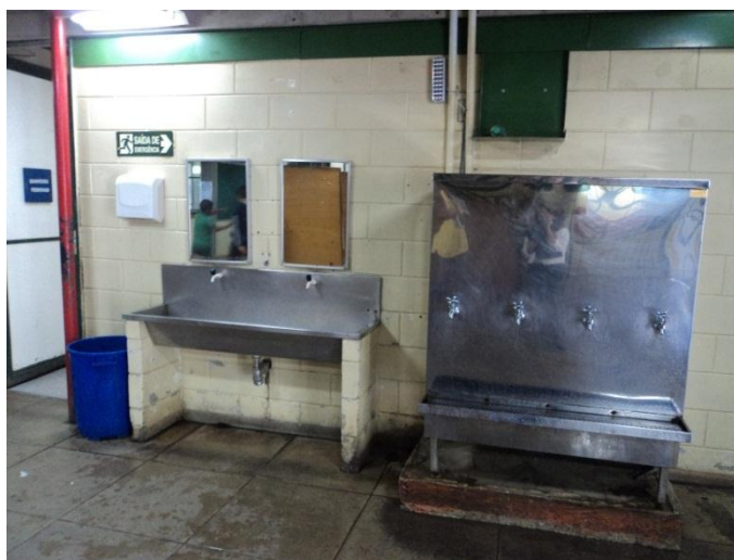
Figura 83: Lavatório e bebedouro (Fonte: a autora, março/2015)
