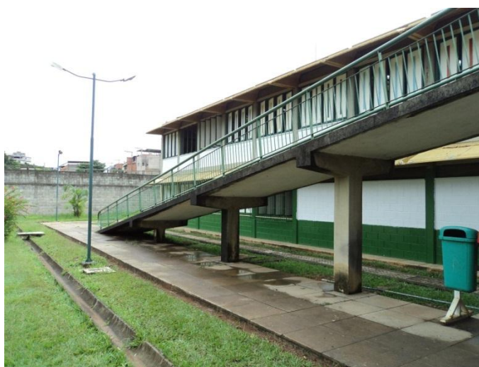
Figura 82: Rampa externa (Fonte: a autora, março/2015)
