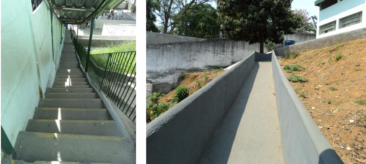
Figura 42: Escada e rampa externas (Fonte: a autora, out/2014)
