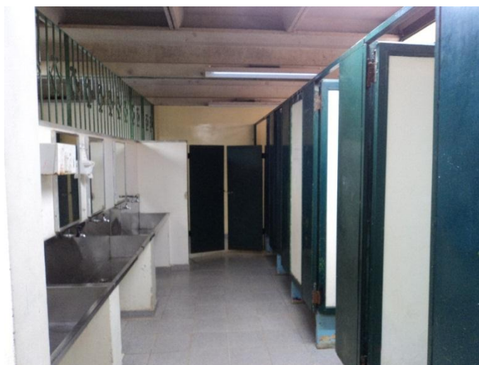
Figura 84: Acesso ao fraldário ( Fonte: a autora, março/2015)
