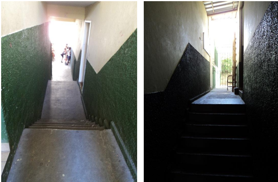
Figura 62: Fotos da circulação do edifício 02 com seus diferentes níveis interligados exclusivamente por escadas (Fonte: a autora, fev/2014)
