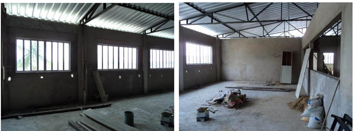
Figura 25: Obras da nova biblioteca (primeiro pavimento) (Fonte: a autora, out/2014)
