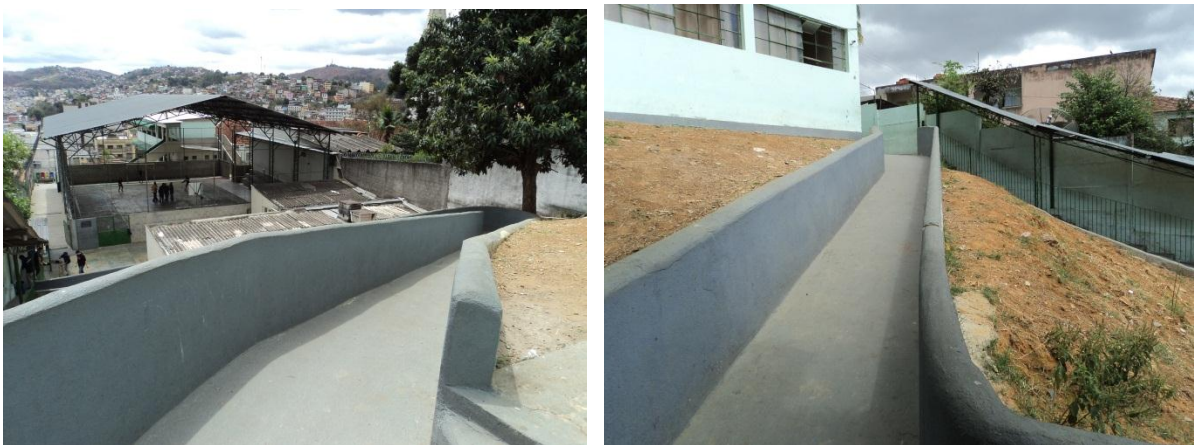
Figura 32: Rampa externa (Fonte: a autora, out/2014)
