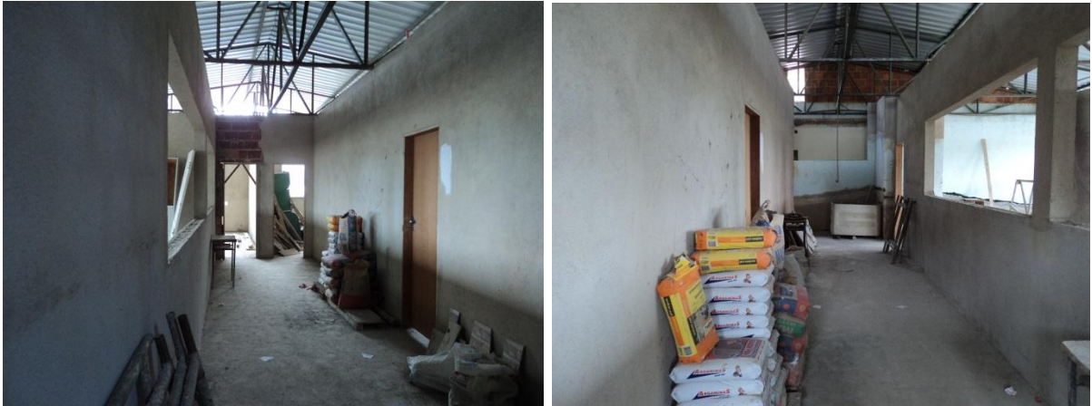
Figura 24: Obras do primeiro pavimento (Fonte: a autora, out/2014)
