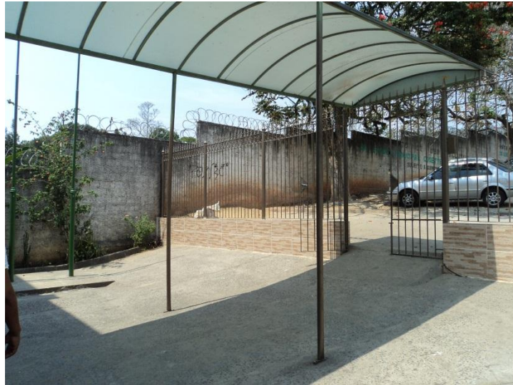
Figura 40: Rampa na entrada da escola (Fonte: a autora, out/2014)
