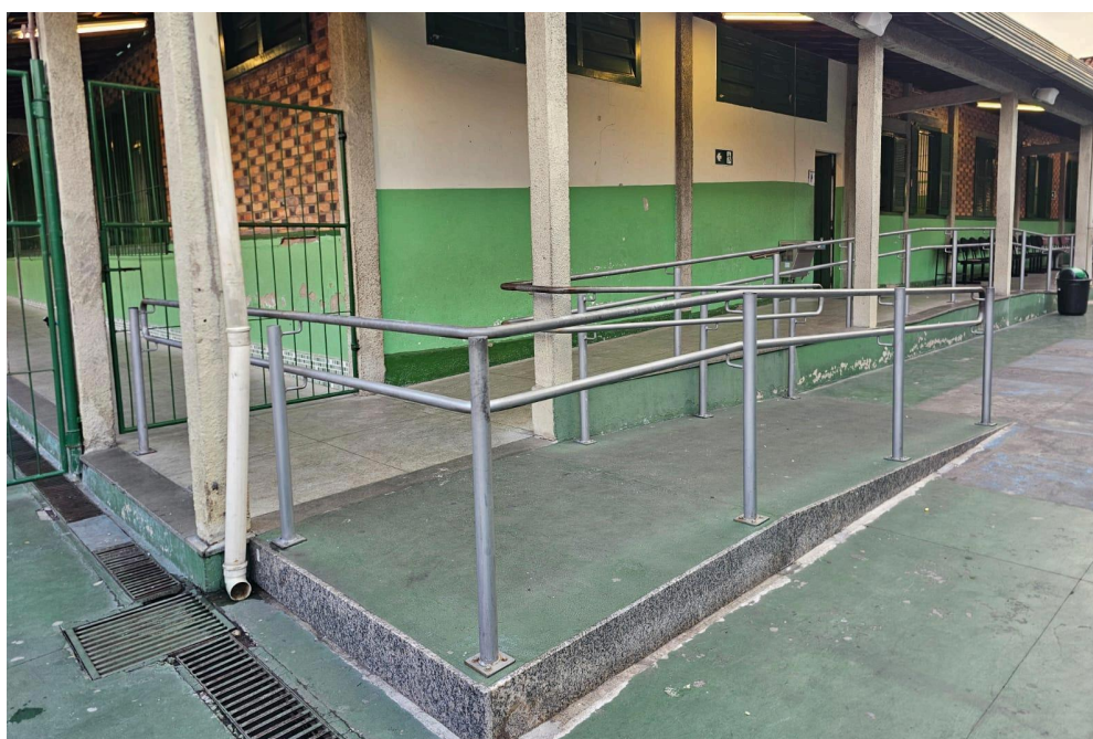
Figura 17 - Acesso para cadeirantes ao pátio principal
