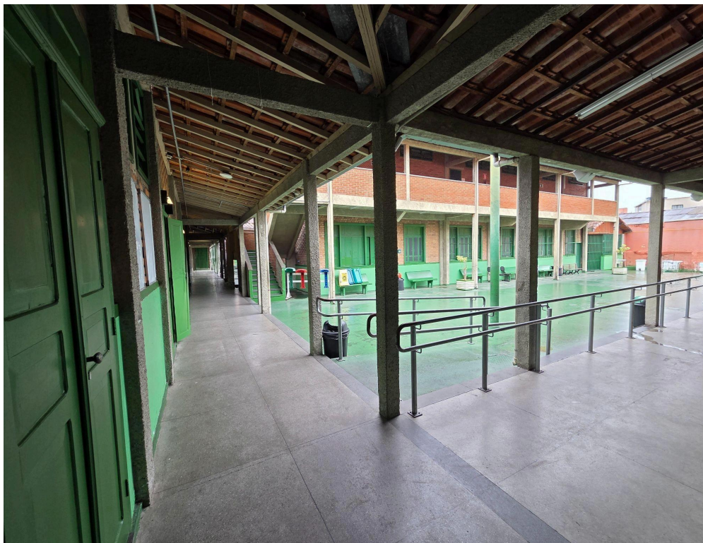
Figura 11 – segundo andar da escola
