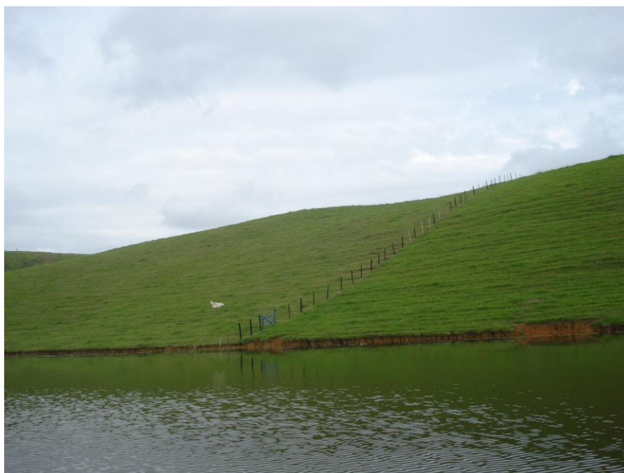
Fotografia 21: Margem esquerda da represa, na direção e à montante do PR2: não apresenta ocupações e não possui sinais de erosões, apesar da ausência de mata ciliar (março de 2010).
