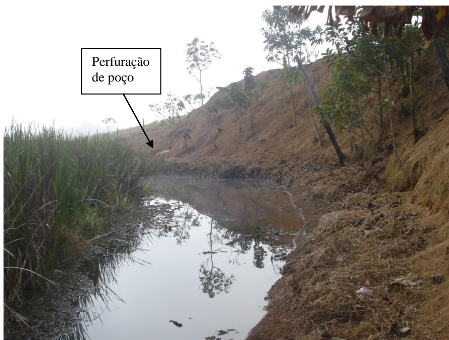
Fotografia 19: Ilegalidades observadas: perfuração de poço sem autorização e remoção da vegetação ciliar na margem esquerda do córrego da Grama (junho de 2010).
