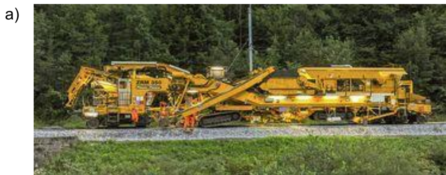
Figura 4 - Desguarnecimento. a) desguarnecedora bimodal; b) processo de introdução e distribuição de lastro desguarnecido.
