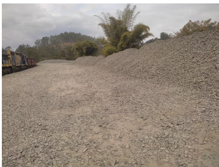
Figura 19 – Local de retirada do material na pedreira de Juiz de Fora
