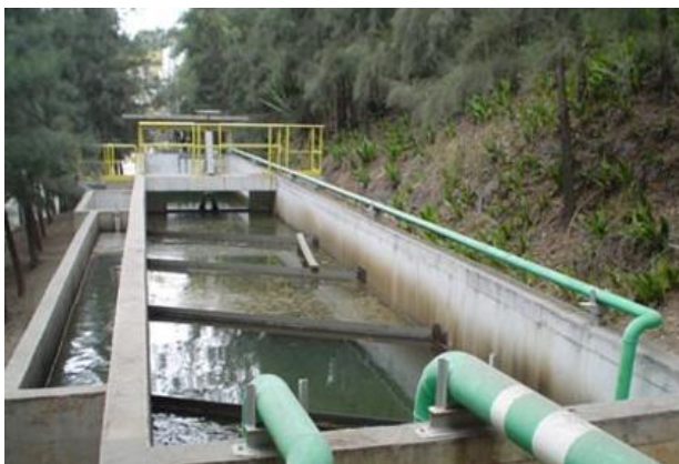
Figura 8: Caixa separadora de óleos e gordura Fonte: www.nobreengenharia.com.br
