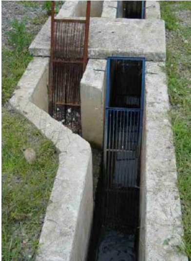
Figura 4: Sistema de gradeamento com limpeza manual Fonte: von SPERLING, 2005
