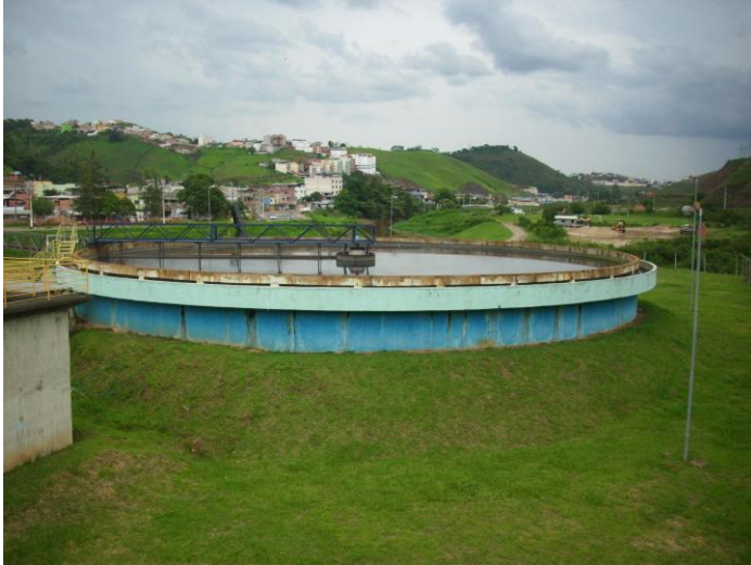
Figura 10: Decantador circular com raspagem mecanizada de lodo – ETE Barbosa Lage- CESAMA, Juiz de Fora Fonte: Acervo do autor, 2010
