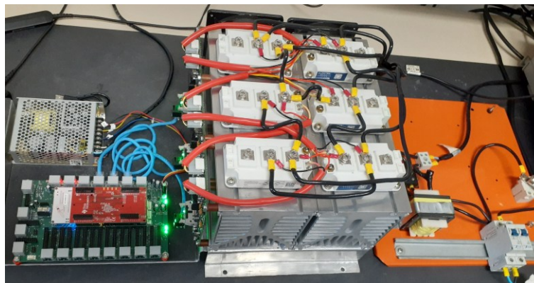
Figura 144 – Protótipo do inversor VSI 5L-3SSC montado em bancada, com cabeamento de potência e comando para os ensaios experimentais.
