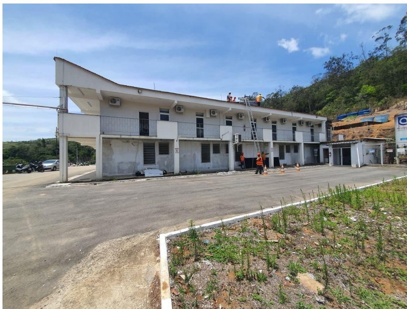
Figura 12 – Vista da Fachada da Edificação Analisada
