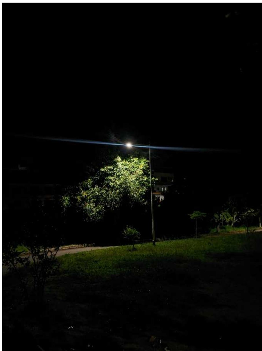
Figura 22 - Sobramento devido a distância entre postes.
